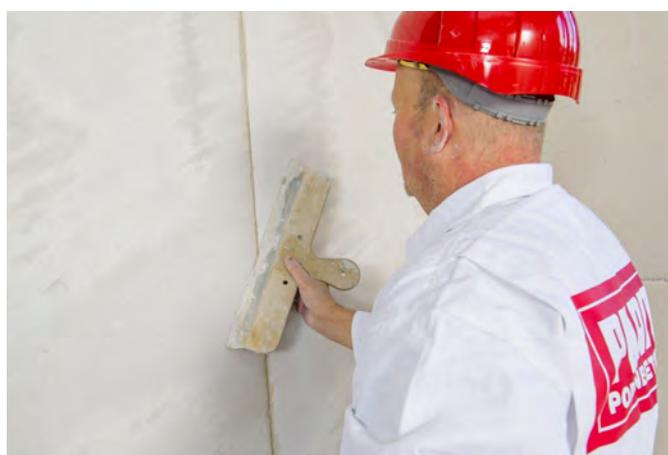
Die vertikalen Anschluss- und Bewegungsfugen sind mit einem ca. 10 cm breiten Gewebestreifen zu überspannen und anschließend zu überarbeiten.
