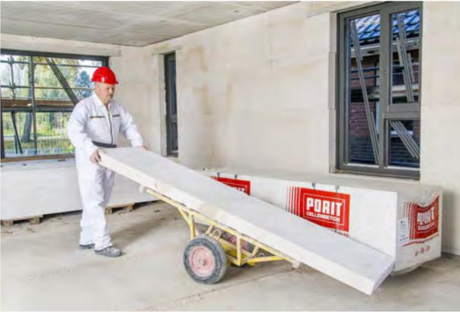
Die Lieferung der PORIT Schnellbau-Elemente ist so zu terminieren, dass diese vor dem Auflegen der jeweiligen Geschossdecke in das entsprechende Geschoss gehoben werden können. Ein spezieller Montagewagen vor Ort erleichtert sowohl den Transport, als auch das Absetzen und Aufrichten der Elemente.
