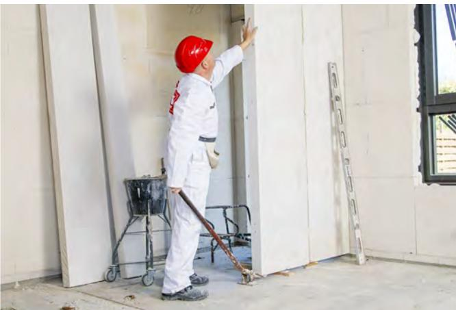
Mit Hilfe des Montagewagens wird das Element nun gekippt, aufgerichtet und ausgerichtet. Mit dem Montagehebel wird es anschließend unter die Decke gedrückt und am Fuß mit einem Holzkeil fixiert.
