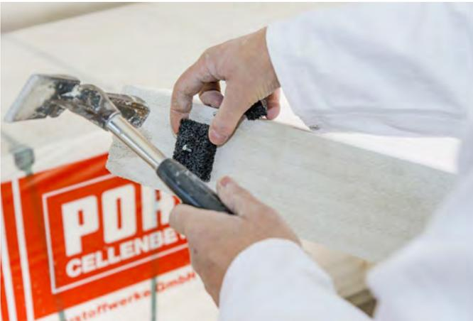
An den flankierenden Bauteilen (Deckenunterseite, Wand) wird der Wandverlauf mittels Schlagschnur angezeichnet. An den Element-Anschlussseiten zur Decke bzw. zur Wand hin, werden Gummiblöcke mit Nägeln oder einem Tacker geheftet.
