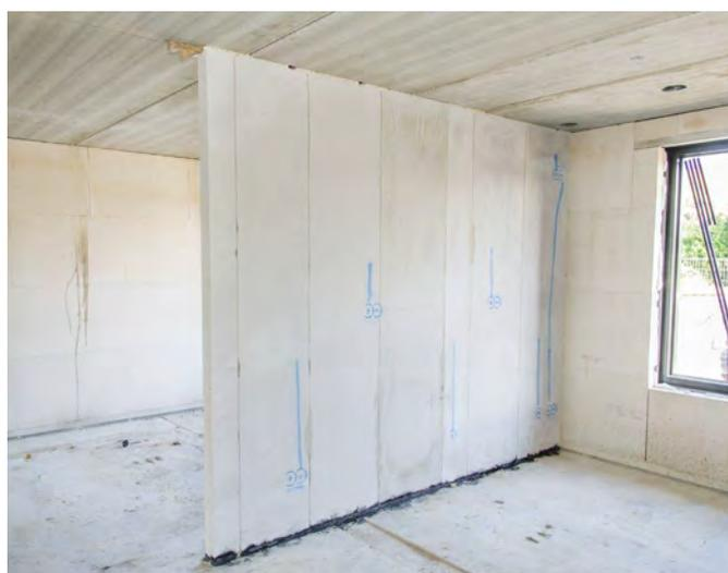
Die Wände sind nach einer Grundierung sofort tapezierfähig. Fliesen können direkt mit einem geeigneten Fliesenmörtel auf die Wand verlegt werden (Bewegungsfugen in den Wänden sind hierbei in der Verfliesung fortzuführen). Für einen Anstrich ist ein vollflächiger Dünnlagen- oder Innenputz erforderlich.
