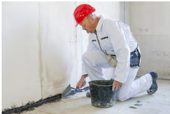
Abschließend wird die Fuge am Fuß der PORIT Schnellbau-Elemente vermörtelt.
