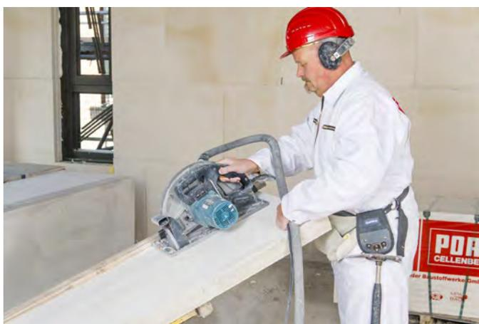
Die Längstrennung von Passelementen erfolgt durch eine Porenbeton- oder Handkreissäge mit Staubabsaugung. Zum Sägen von Schräg- oder Querschnitten ist ein Diamantsägeblatt erforderlich, da die Elemente in Längsrichtung eine Transport- bzw. Montagebewehrung enthalten.
