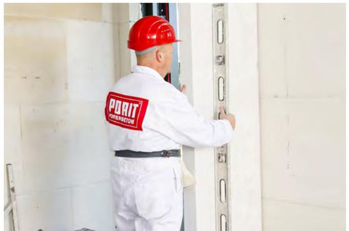
Während mit der Wasserwaage oder dem Richtscheit das Lot kontrolliert wird, können bereits die nächsten Elemente transportiert und aufgerichtet werden.
