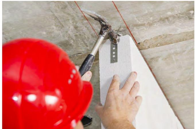
Der zuvor an die Decke gedübelte Federanker wird zurückgebogen und an der Stirnseite des Elements festgenagelt. Je Stoßfuge ist ein Federanker einzubauen.
