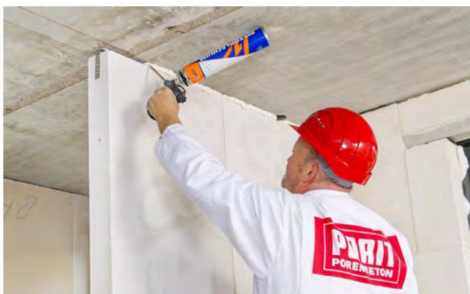
Die Anschlussfugen an der Decke und den anschließenden Wänden werden mit Montageschaum oder Mineralwolle geschlossen.
