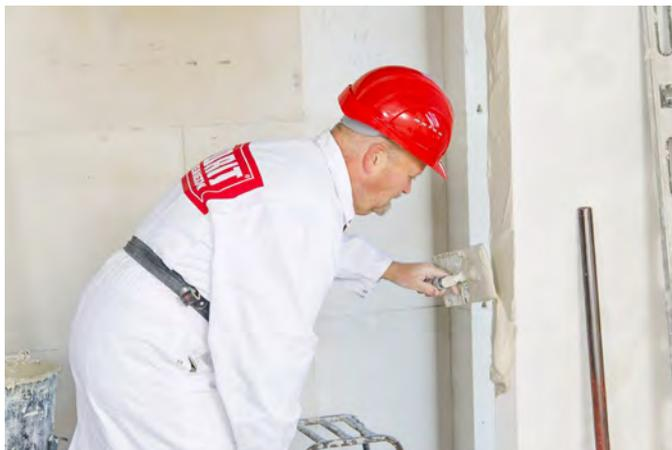
Vor der Montage jedes weiteren Elements ist jedoch auf der senkrechten Anschlussfuge des bereits stehenden Elements ca. 3 mm Dünnbettmörtel mit einer geeigneten Zahnkelle aufzutragen.
