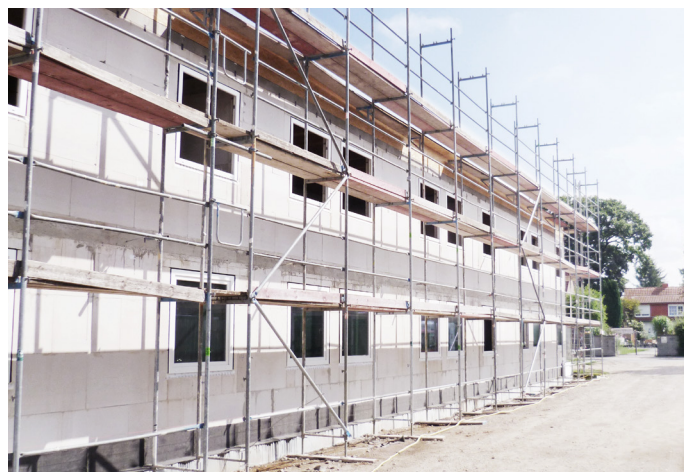
Verkürzung von Bauzeiten durch schnell wachsende Kalksandsteinwände.
