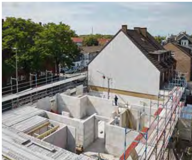
KS-Kreislaufsteine wurden bei der Errichtung eines viergeschossigen Wohnungsbaus in Hamm eingesetzt. © Olaf Mahlstedt / KS-ORIGINAL
