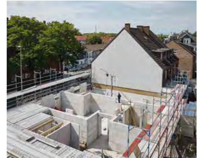
KS-Kreislaufsteine wurden bei der Errichtung eines viergeschossigen Wohnungsbaus in Hamm eingesetzt. © Olaf Mahlstedt / KS-ORIGINAL
