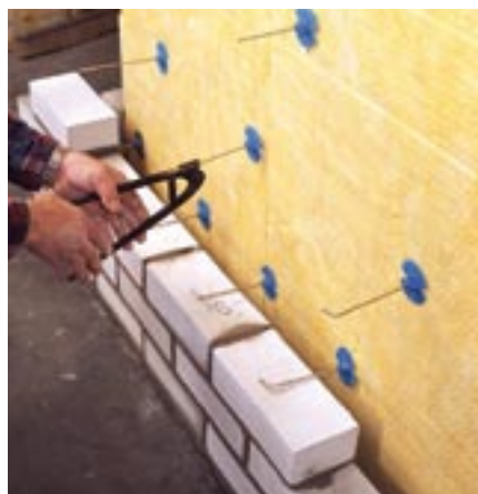
Bild 10: Dübelanker mit Klemm- und Abtropfscheibe im eingebauten Zustand (links) und als Prinzipskizze (rechts)
