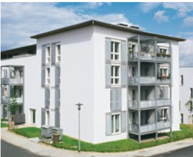
Bild 1: Außenwand mit KS-Thermohaut
