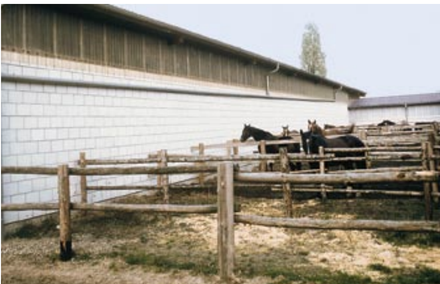
Bild 75: Einschalige KS-Außenwand bei einem Reitstall
