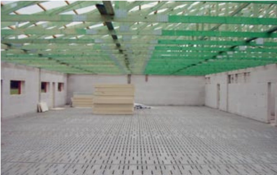
Bild 74: Rohbau eines Maststalls
