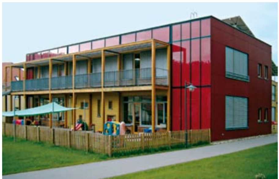
Bild 68: Kindergarten und Kindertagesstätte in Dohna – Fassadenkollektoren und vorgehängte Fassade in einem Farbton
