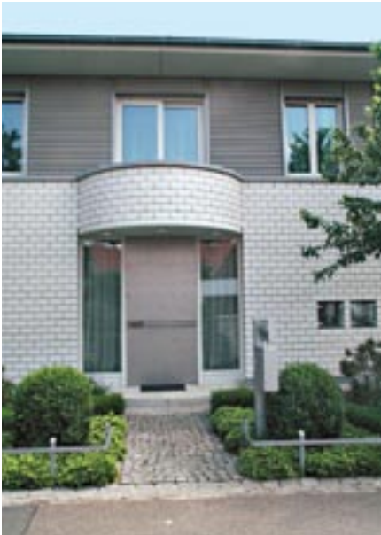
Bild 43: Sichtmauerwerk aus KS-Verblendern kombiniert mit vorgehängter hinterlüfteter Fassade.
