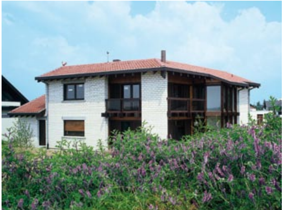
Bild 6: Sichtmauerwerk aus KS-Verblendern, Format 2DF
