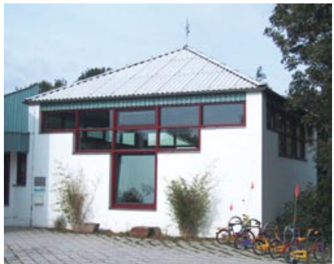
Bild 2: Einfarbig gestrichenes KS-Verblendmauerwerk
