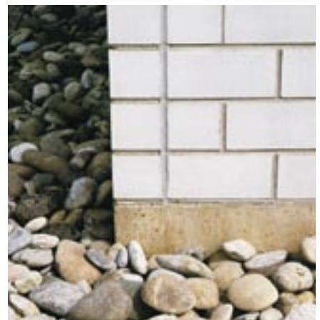
Bild 17: Ausführung einer Dehnungsfuge an einer Gebäudekante mit spritzbarem Fugendichtstoff
