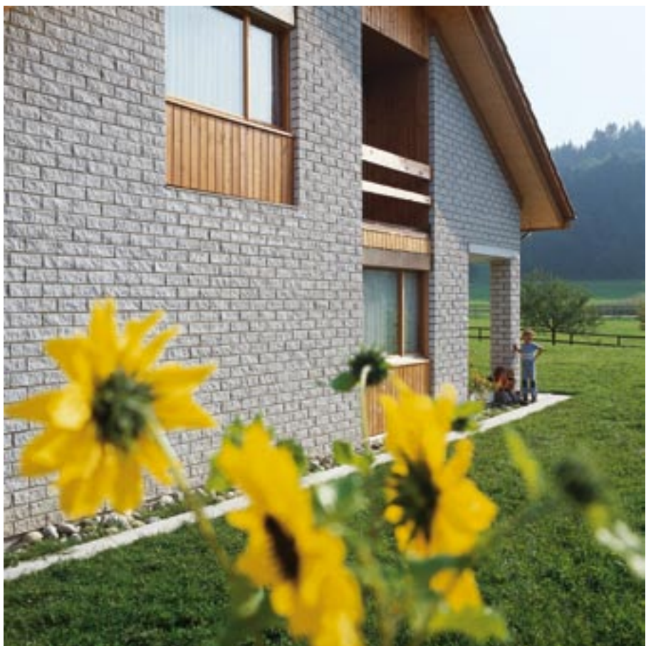
Bild 7: Sichtmauerwerk aus bruchrauen KS-Verblendern, Format NF
