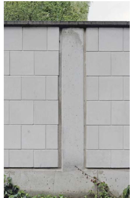
Bild 73: Frei stehende KS-Wand mit Aussteifungen
