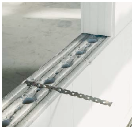
Bild 35: Mörtelbett mit Edelstahl-Flachanker
