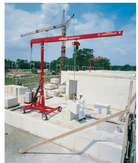
Bild 25: Arbeiten mit dem Versetzgerät
