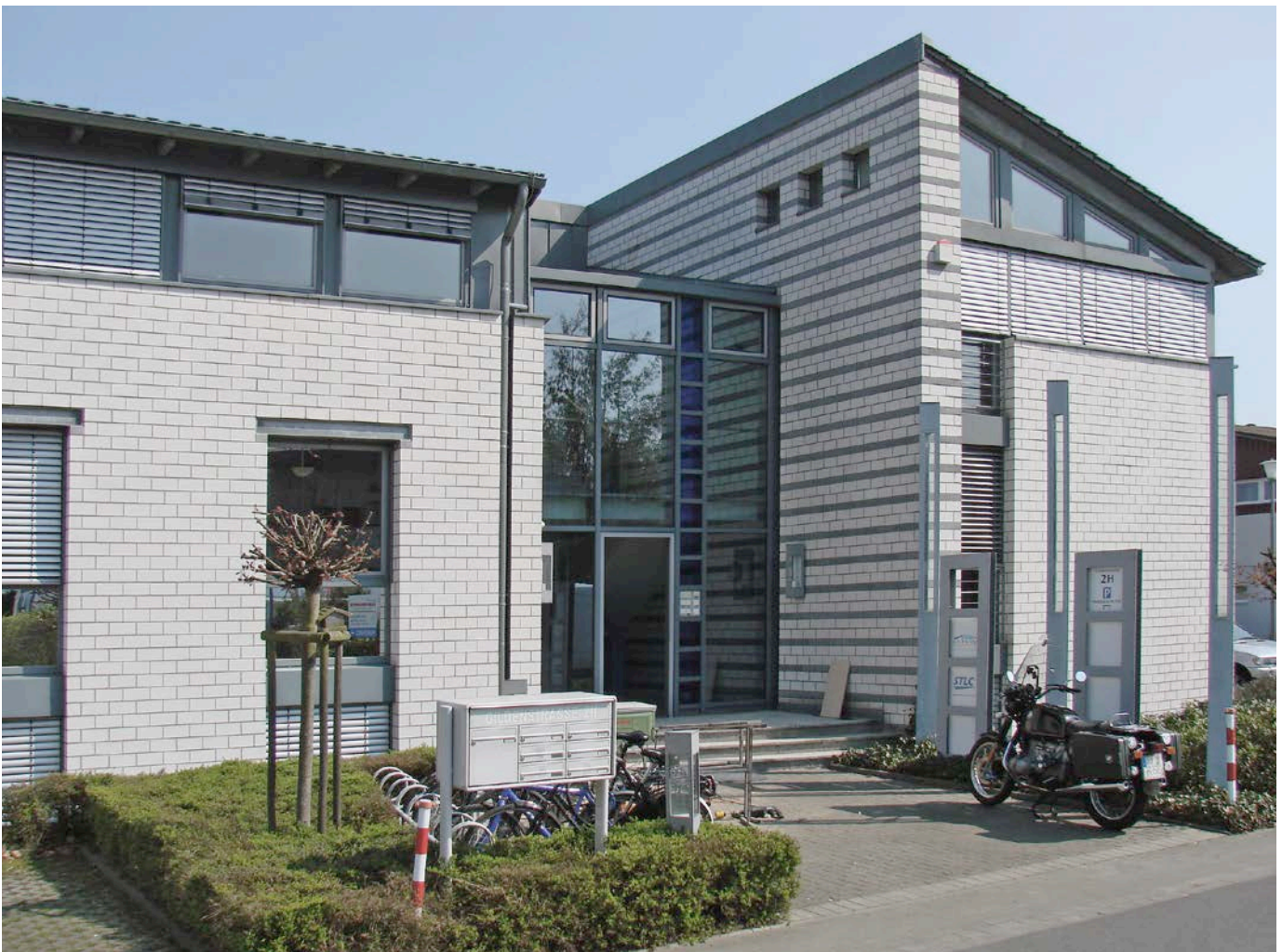
Bild 27: Gebäudeensemble aus Sichtmauerwerk in Kalksandstein
