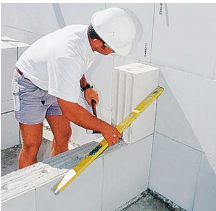
Bild 22: Ausrichten des Steins
