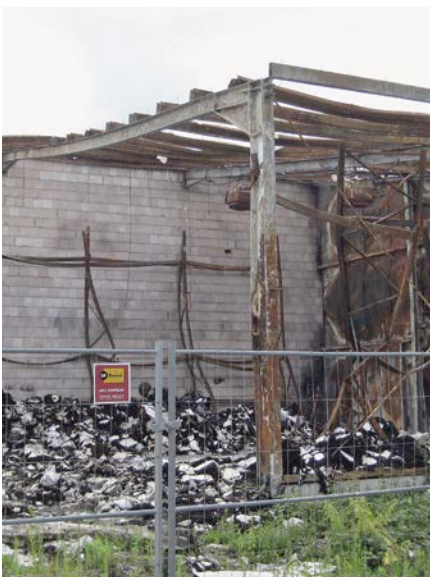
Bild 16: Durch Brand verformte Stahlkonstruktion vor unversehrter Kalksandsteinwand
