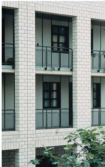
Bild 21: Sichtmauerwerk aus KS-Verblendern, farblos imprägniert, Gebäudetrennfuge in einem Pfeiler
