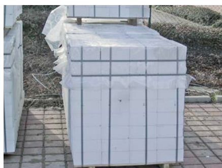
Bild 13: Lagern von Steinen mit Schutz gegen Niederschlag
