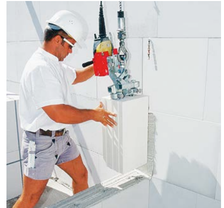
Bild 21: Ersten Stein setzen
