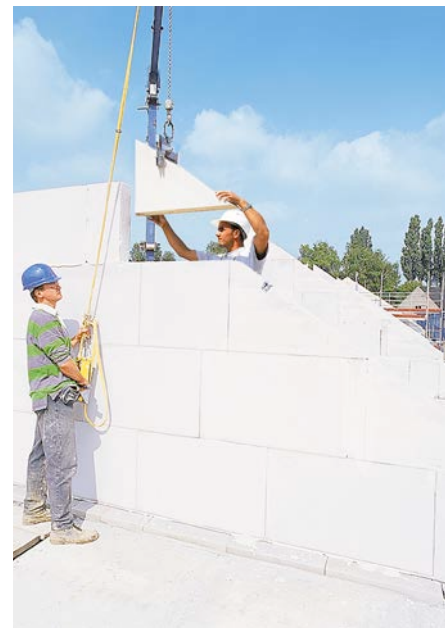
Bild 12: Vermauern von KS XL-Planelementen
