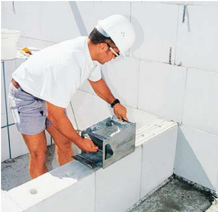
Bild 19: Lagerfugenmörtel mit Mörtelschlitten aufziehen
