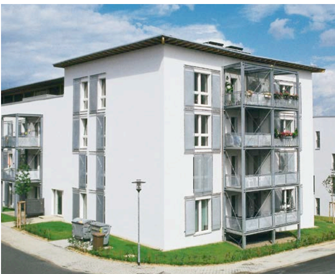
Bild 1: Außenwand mit Wärmedämm-Verbundsystem
