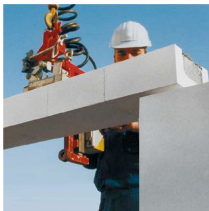
Bild 14: Vorgefertigte KS-Flachstürze zur schnellen und rationalen Öffnungsüberdeckung
