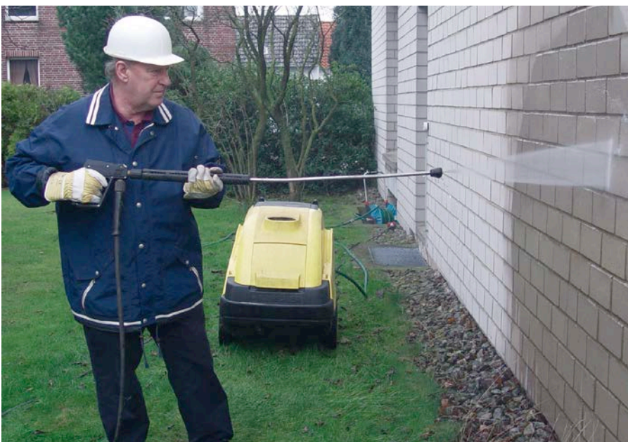
Bild 24: Reinigung mit Hochdruckreiniger
