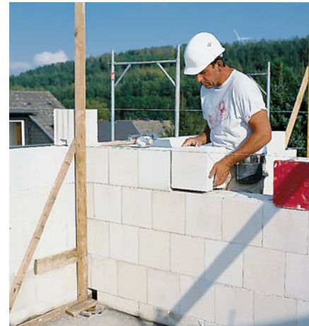
Bild 5: Versetzen von Plansteinen in Dünnbettmörtel
