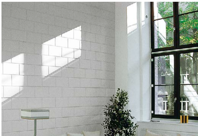
Bild 7: Innensichtmauerwerk aus KS-Fasensteinen, weiß gestrichen
