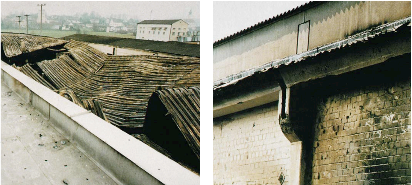
Bild 21: KS-Brandwand nach einem Brandereignis mit richtigem Dachanschluss
