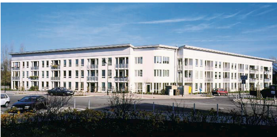
Bild 2: Kompakte Gebäudeformen sind energetisch vorteilhaft.
