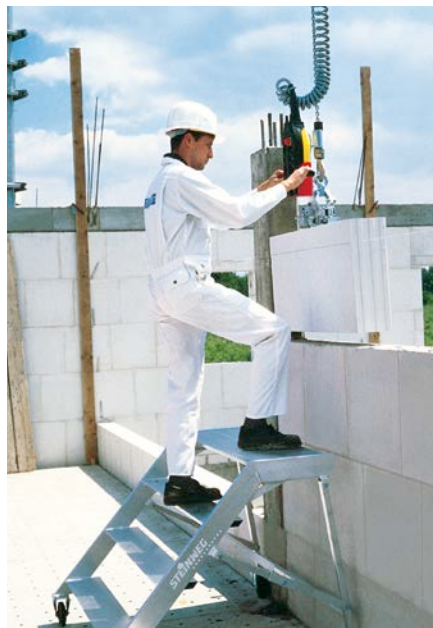
Bild 11: Vermauern von KS XL-Rasterelementen
