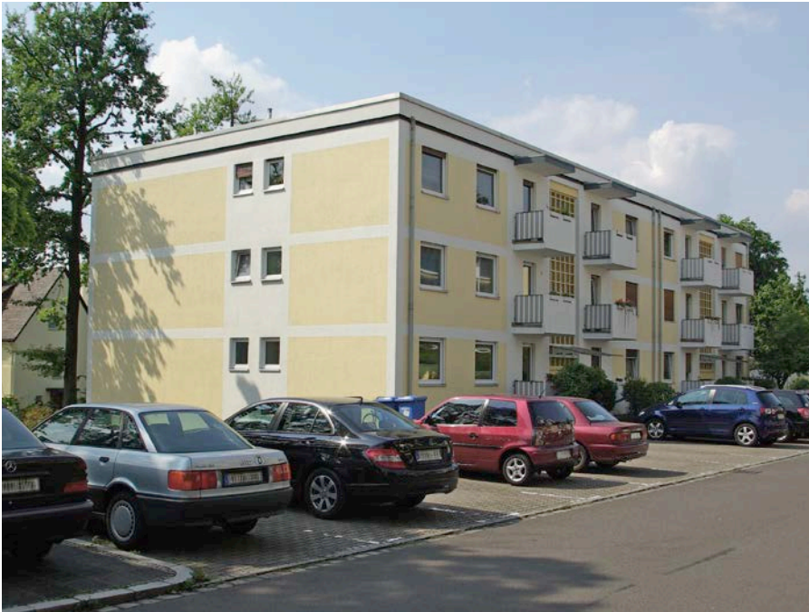
Bild 29: Mehrfamilienhaus aus KS-Mauerwerk mit WDVS aus dem Jahr 1968
