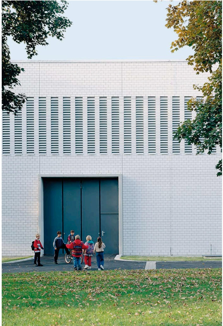
Bild 28: Sichtmauerwerk aus KS-Verblendern, farblos imprägniert, im Industriebau
