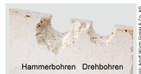
Bild 6: Unterschiedliche Vorschädigung durch Hammer- und Drehbohren auf der Rückseite
