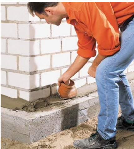
Bild 9: Herstellen der Hohlkehle, Querschnittsabdichtung mit Dichtschlämme
