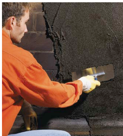
Bild 10: Aufziehen der kunststoffmodifizierten Bitumendickbeschichtung mit der Glättkelle
