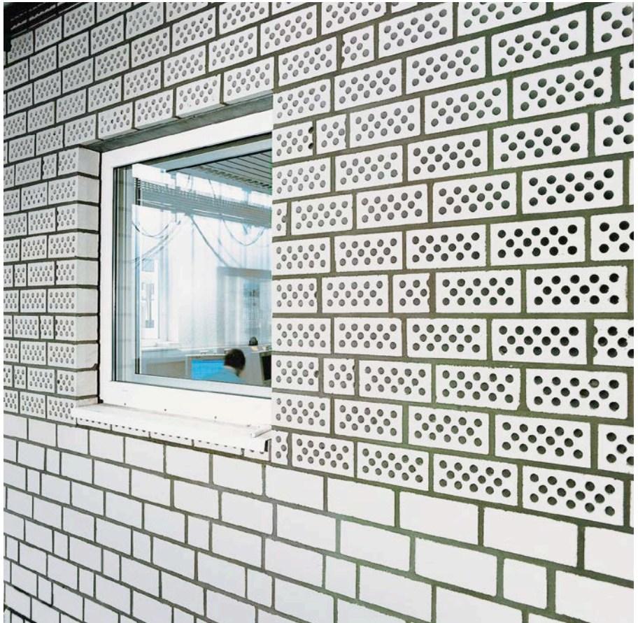
Bild 44: Schallschluckwand aus KS-Schallschlucksteinen (Lochsteine, werkseitig durchstoßen)
