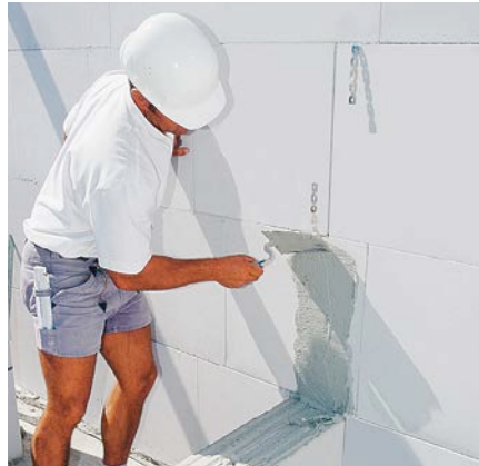
Bild 20: Mörtel für Anschlussfuge auftragen
