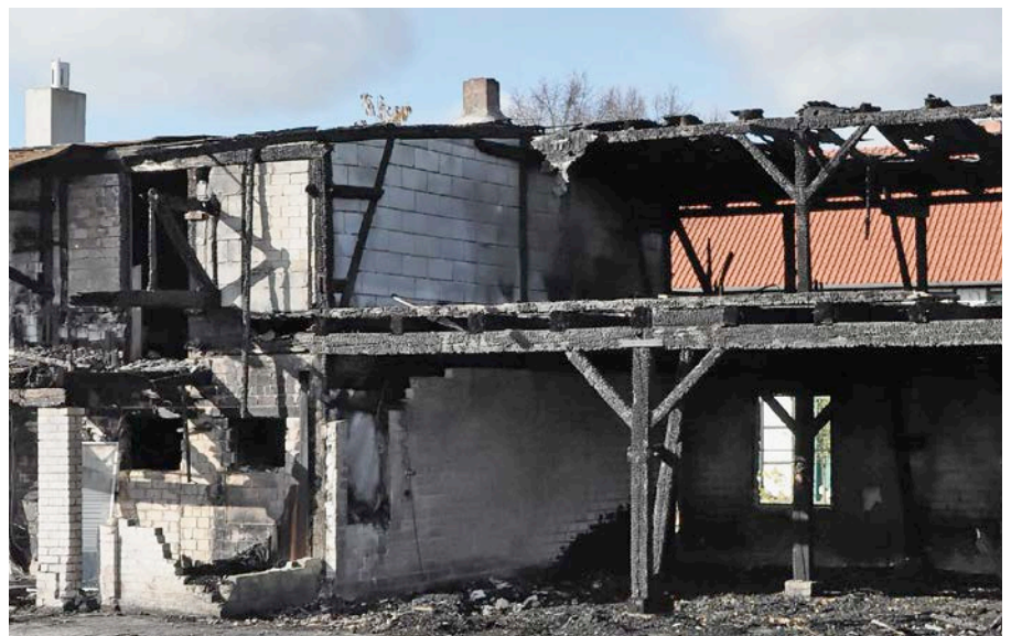
Bild 17: Durch einen Brand verkohlte Holzkonstruktion vor einer unversehrten Kalksandsteinwand; wegen ungetrennten Dachanschlüssen wurde das Feuer weitergeleitet.
