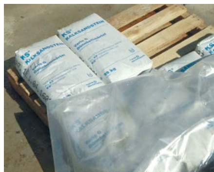
Bild 2: Werk-Trockenmörtel ist vor Witterungseinflüssen zu schützen.
