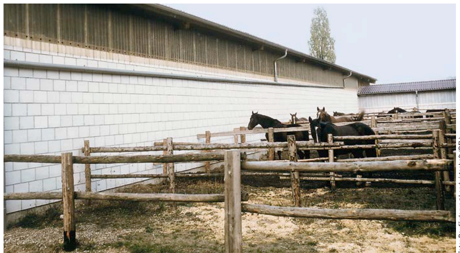
Bild 72: Einschalige KS-Außenwand bei einem Reitstall
