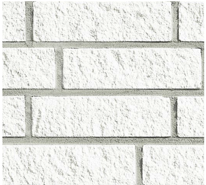
Bild 4: Sichtmauerwerk aus bruchrauen KS-Verblendern, Format NF
