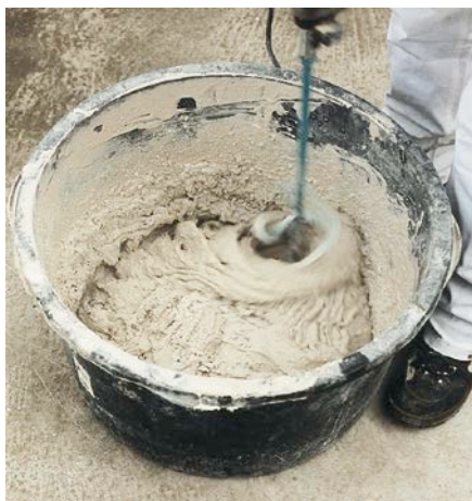
Bild 3: Mischen von Dünnbettmörtel
