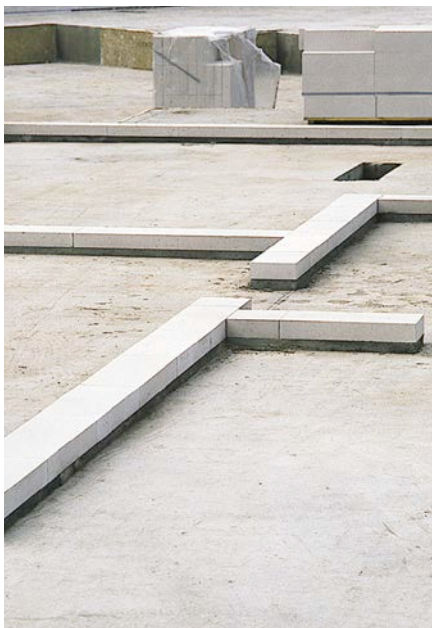
Bild 10: Anlegen der Kimmerschicht
