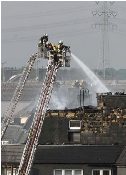
Bild 30: Brand eines Dachgeschosses – Kalksandstein-Treppenraumwände wiederverwendbar
