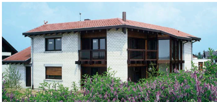
Bild 6: Sichtmauerwerk aus KS-Verblendern, Format 2DF
