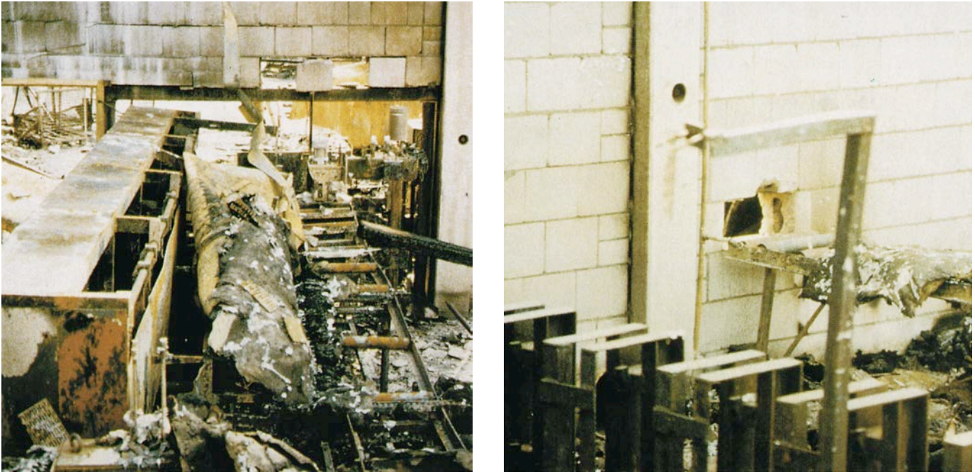
Bild 27: Brandwand mit nicht ordnungsgemäß ausgeführten Verschlüssen nach einem Brandereignis
