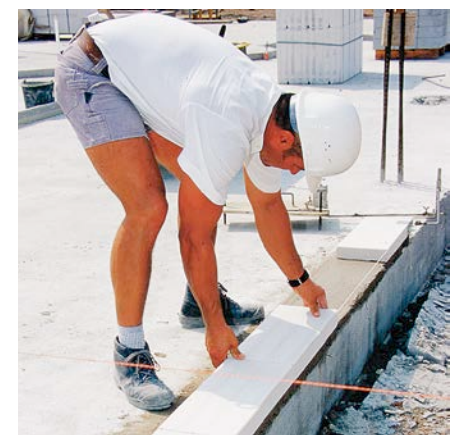
Bild 18: Kimmsteine im Mörtelbett verlegen
