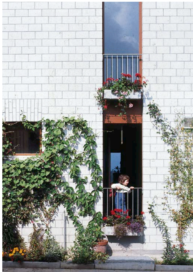
Bild 9: Sichtmauerwerk aus KS-Verblendern im Format 2 DF, farblos imprägniert, Mauerverband mit halbsteiniger Überdeckung
