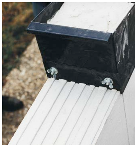
Bild 4: Mörtelauftrag mit Mörtelschlitten
