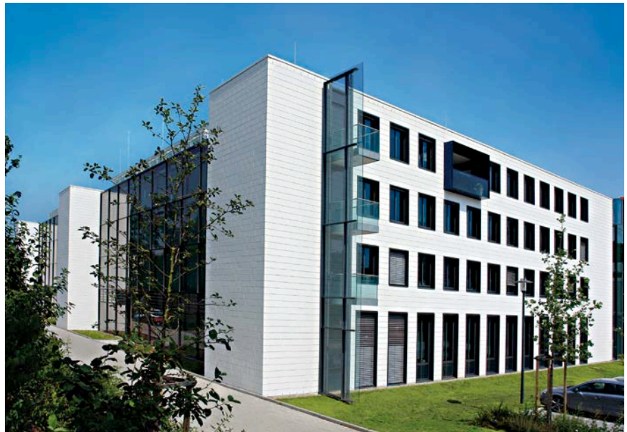
Bild 22: Sichtmauerwerk aus KS-Verblendern, farblos imprägniert, mit hellem Fugenmörtel
