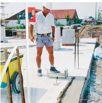
Bild 16: Mörtel für die Kimmschicht aufziehen
