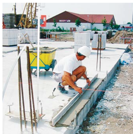
Bild 17: Mörtel planeben abziehen
