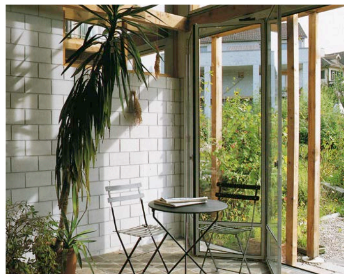
Bild 2: Innensichtmauerwerk aus KS-Verblendern
