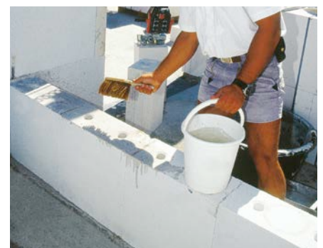
Bild 14: Bei sehr trockenen Steinen sind diese vorzunässen.
