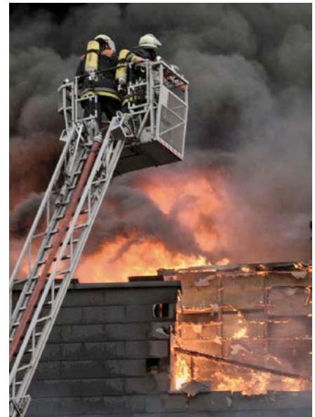
Bild 30: Brand eines Dachgeschosses – Kalksandstein-Treppenraumwände wiederverwendbar
