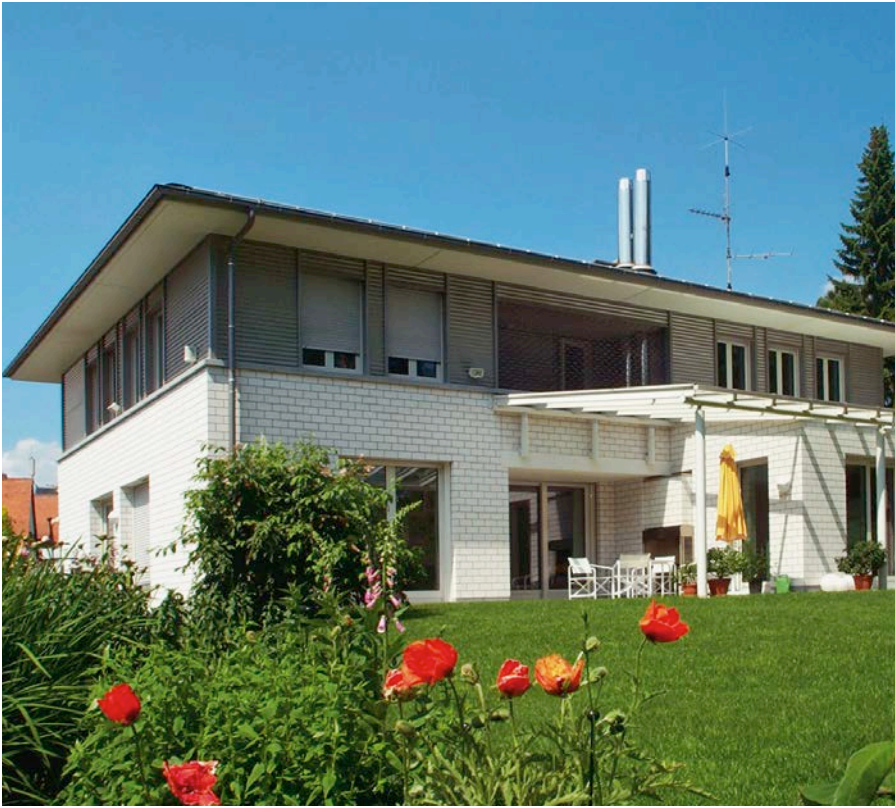
Bild 18: Sichtmauerwerk aus KS-Verblendern im Format 2 DF, farblos imprägniert
