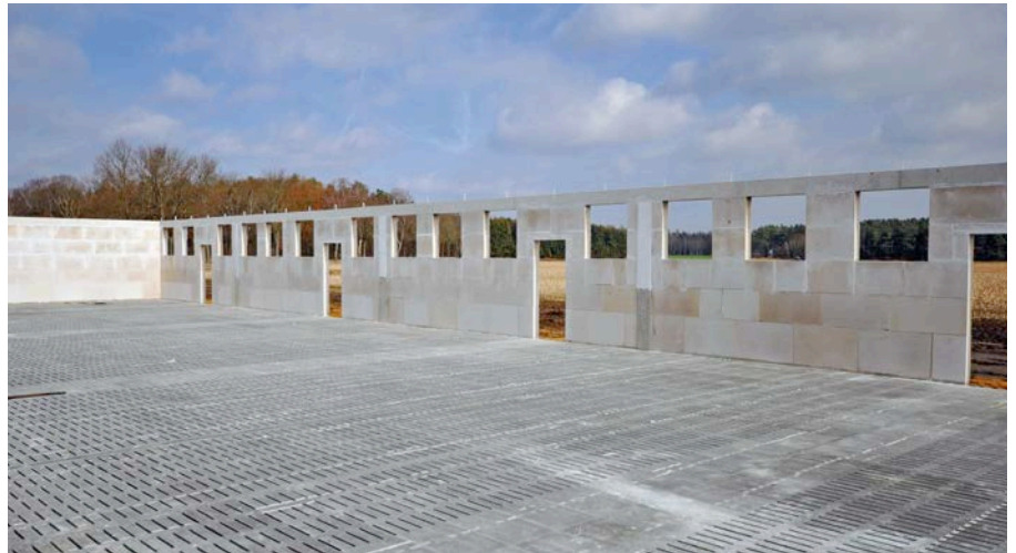
Bild 71: Rohbau eines Maststalls
