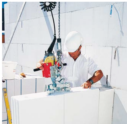
Bild 23: Versetzen der folgenden Steine
