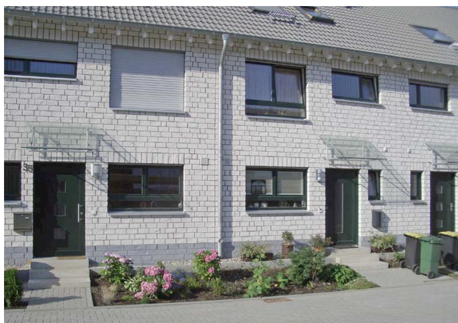
Bild 7: Sichtmauerwerk aus bruchrauen KS-Verblendern, Format 2DF
