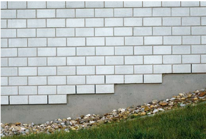
Bild 11: Sichtmauerwerk aus KS-Verblendern, farblos imprägniert, abgetreppter Sockelanschluss bei einem Gebäude in Hanglage
