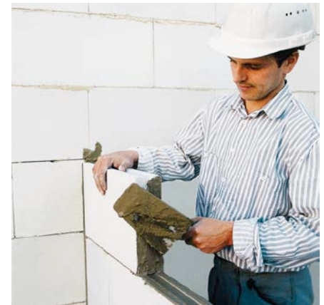
Bild 12: Die Stoßfugen werden bei 7 cm dicken Bauplatten vermörtelt.
