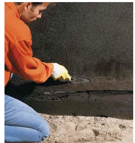
Bild 11: Glattziehen der Hohlkehle mit der Zungenkelle
