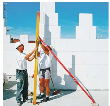
Bild 15: Mauerlehren zur Vereinfachung und Beschleunigung des Bauablaufs
