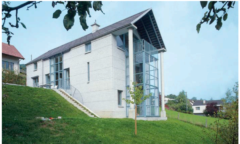
Bild 26: Sichtmauerwerk aus KS-Verblenden, farblos imprägniert
