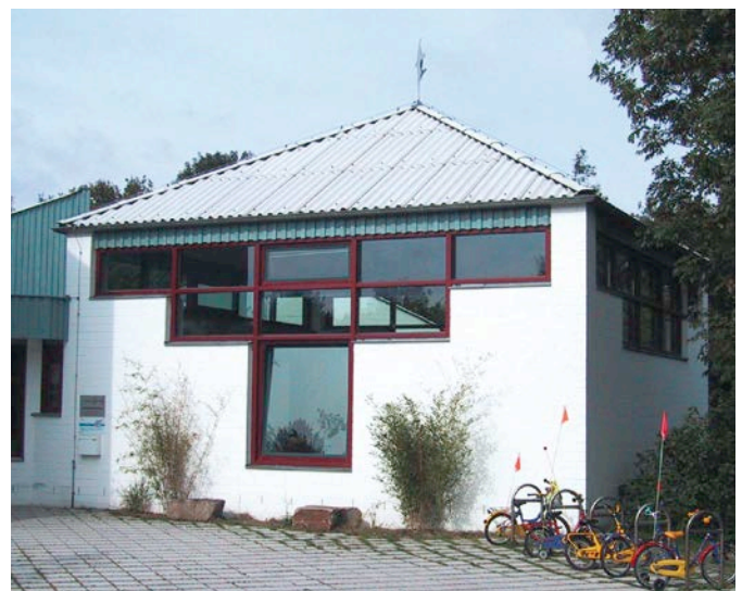
Bild 2: Einfarbig gestrichenes KS-Verblendmauerwerk
