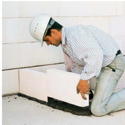
Bild 11: Die erste Steinreihe wird in Normalmauermörtel versetzt.
