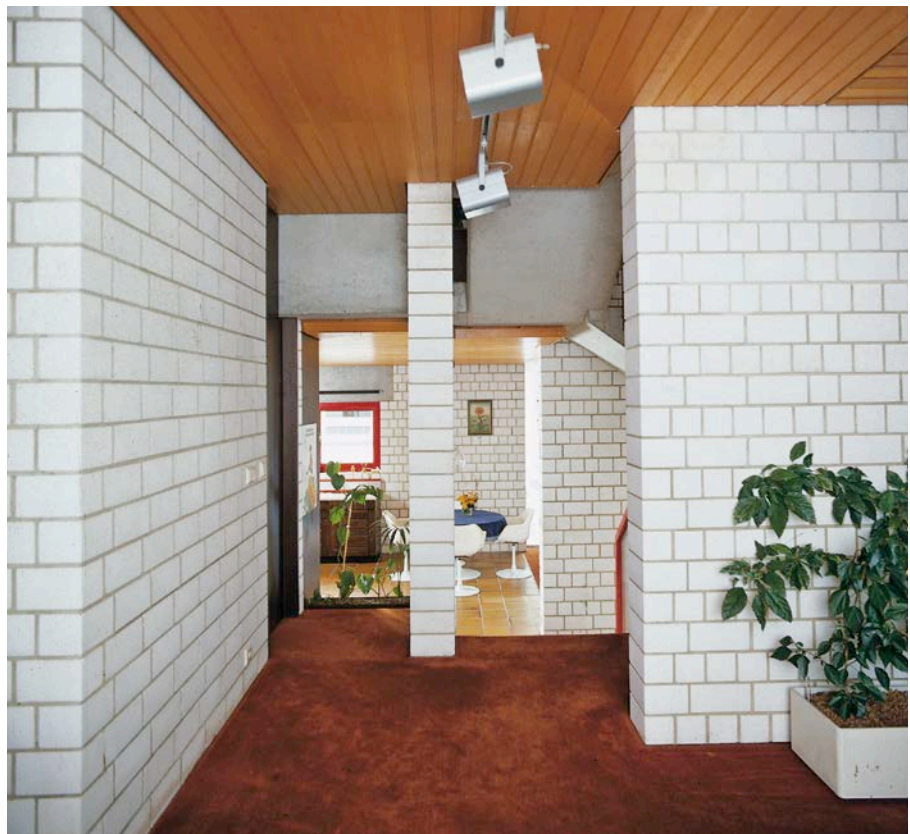
Bild 15: Im Innenbereich sind Kalksandsteinwände mit Sichtmauerwerk Gestaltungselement.
