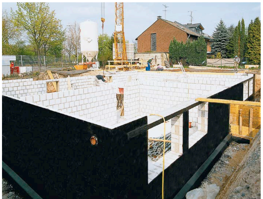
Bild 1: Kellerwände aus KS-Mauerwerk mit kunststoffmodifizierter Bitumendickbeschichtung (KMB)
