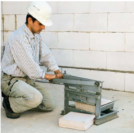
Bild 10: Pass-Stücke werden vor Ort hergestellt.
