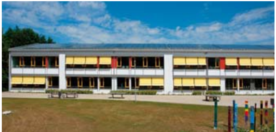
Südansicht – westlicher Bereich des Sekundarbereichs
