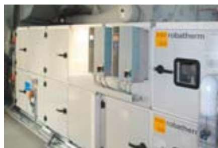
Lüftungsgerät
