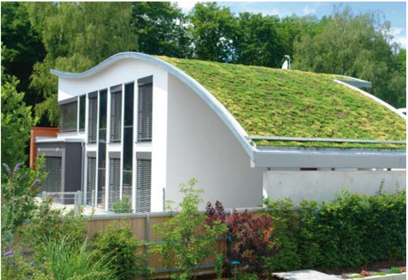
Ansicht von Osten mit Blick auf das Gründach
