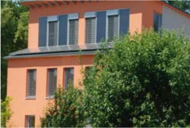
Einfamilienhaus (2008), 90475 Nürnberg, Außenwand: Kalksandstein mit WDVS Entwurf: Schulze Darup & Partner, 90475 Nürnberg, www.schulze-darup.de
