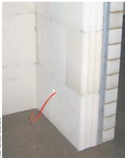
Modell einer zweischaligen Außenwand mit VIP-Dämmung
