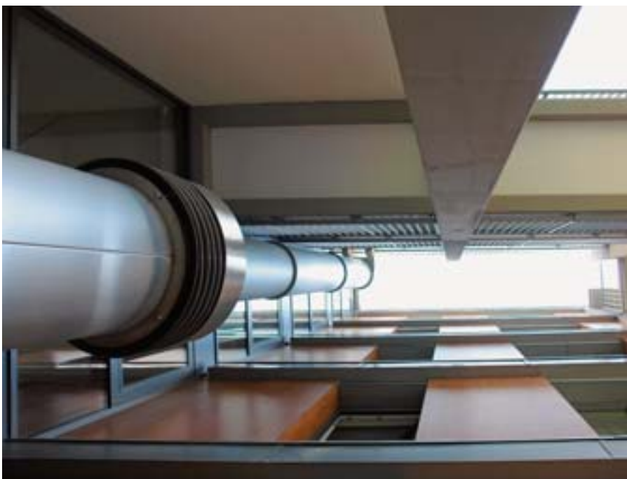
Frischluf- und Fortluftleitung der Lüftungsanlage
