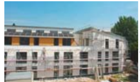
Ansicht Süd (Bauphase)
