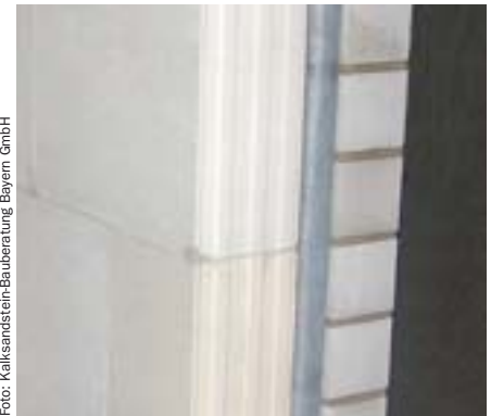
Anschluss Verblendmauerwerk
