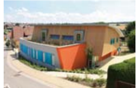
Ansicht von Nordwest
