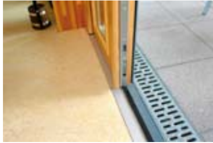
Einbau eines Fensters: barrierearme Schwelle
