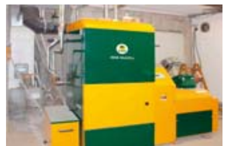
Technikzentrale mit Pelletsessel
