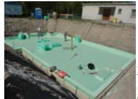
Dämmung unter Bodenplatte
