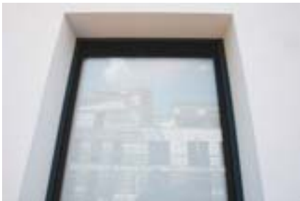
Holz-Alu-Fenster mit Dreischiebenverglasung und vorgesetzter Glasebene zur Integration des Verschattungselements
