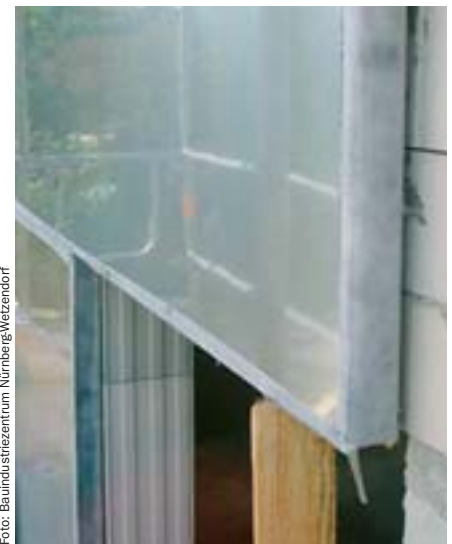
VIP-Dämmung im Bereich der Fenster
