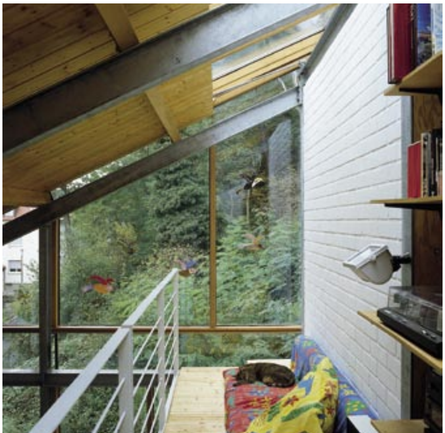
Bild 27: Innensichtmauerwerk aus KS-Steinen, weiß gestrichen
