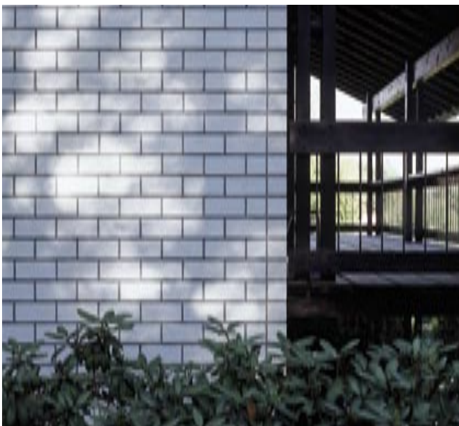
Bild 1: Außensichtmauerwerk aus KS-Verblendern
