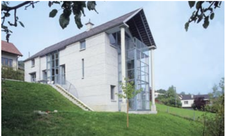
Bild 26: Sichtmauerwerk aus KS-Verblendern, farblos imprägniert
