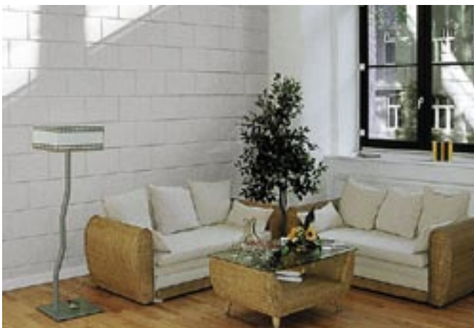
Bild 7: Innensichtmauerwerk aus KS-Fasensteinen, weiß gestrichen
