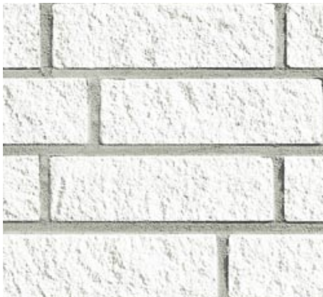
Bild 4: Sichtmauerwerk aus bruchrauen KS-Verblendern, Format NF
