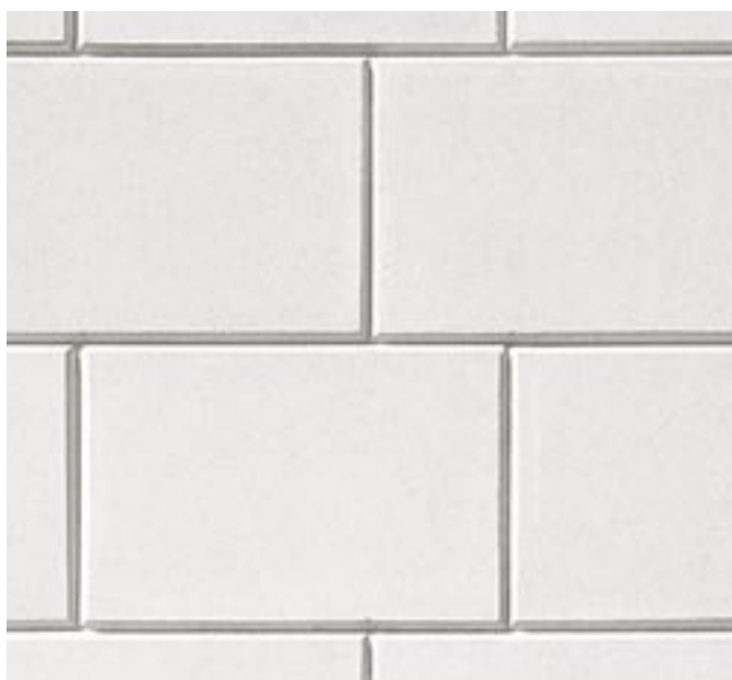
Bild 6: Sichtmauerwerk aus KS-Fasensteinen, außen in Verblenderqualität und mit vermörtelten Stoßfugen
