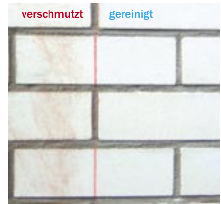
Bild 25: Reinigungseffekt, Beispiel Reinigung mit Schleifpapier, Körnung 140
