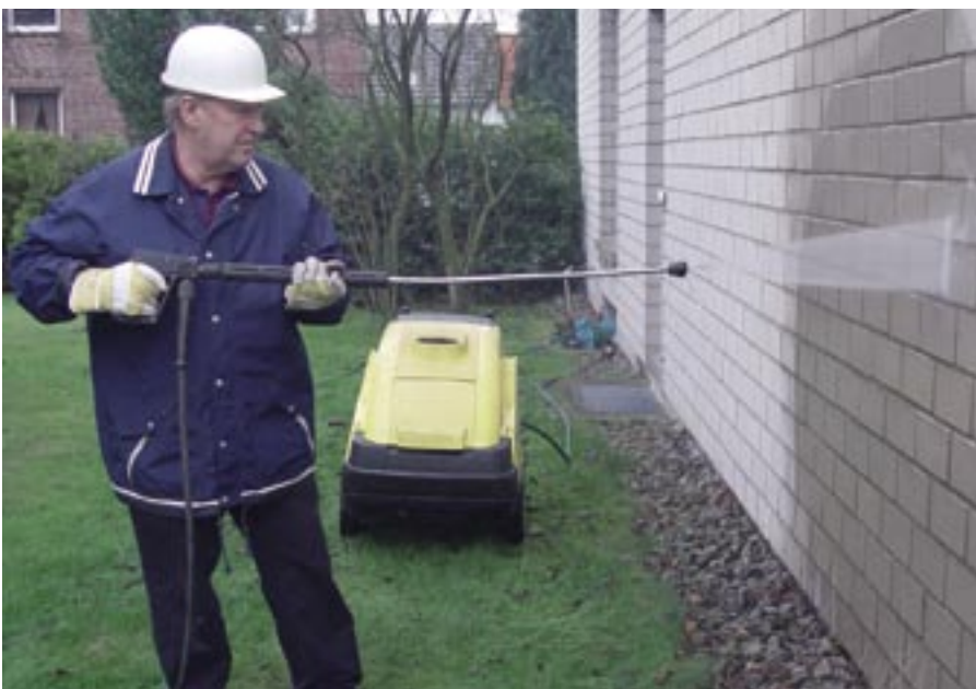
Bild 24: Reinigung mit Hochdruckdampfreiniger
