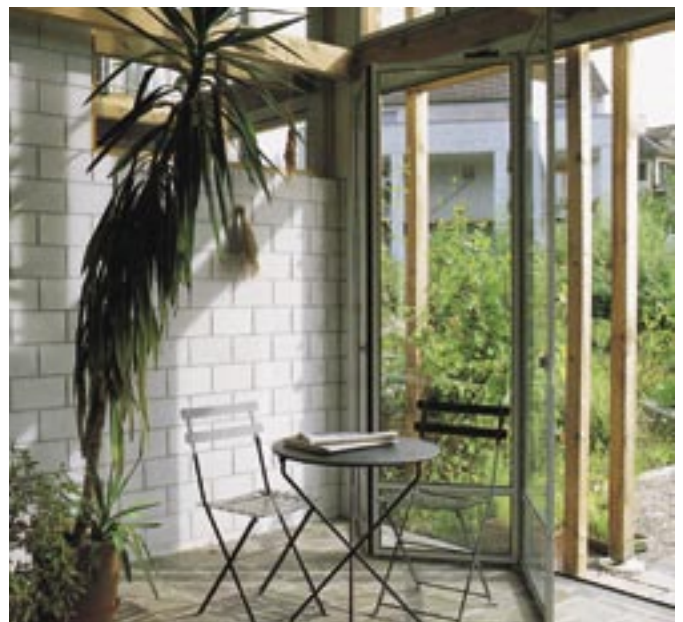
Bild 2: Innensichtmauerwerk aus KS-Verblendern
