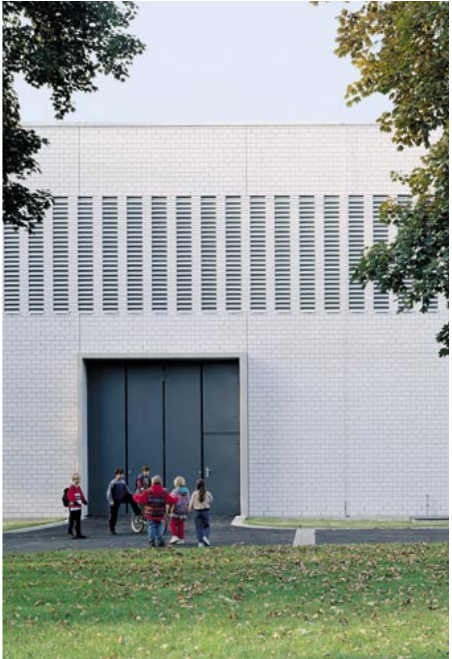
Bild 28: Sichtmauerwerk aus KS-Verblendern, farblos imprägniert, im Industriebau
