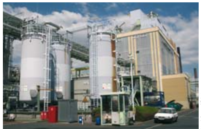
Bild 2: Gebäude der Chemischen Industrie
