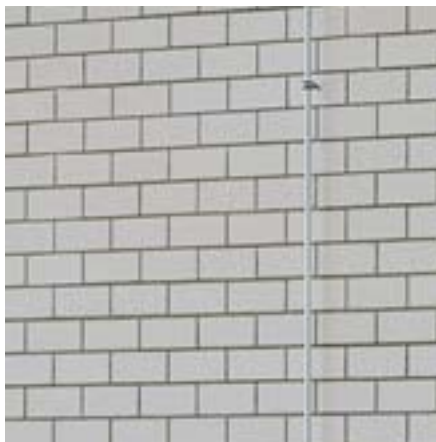
Bild 8: Kleinformatisches, glattes KS-Sichtmauerwerk, Format 2 DF
