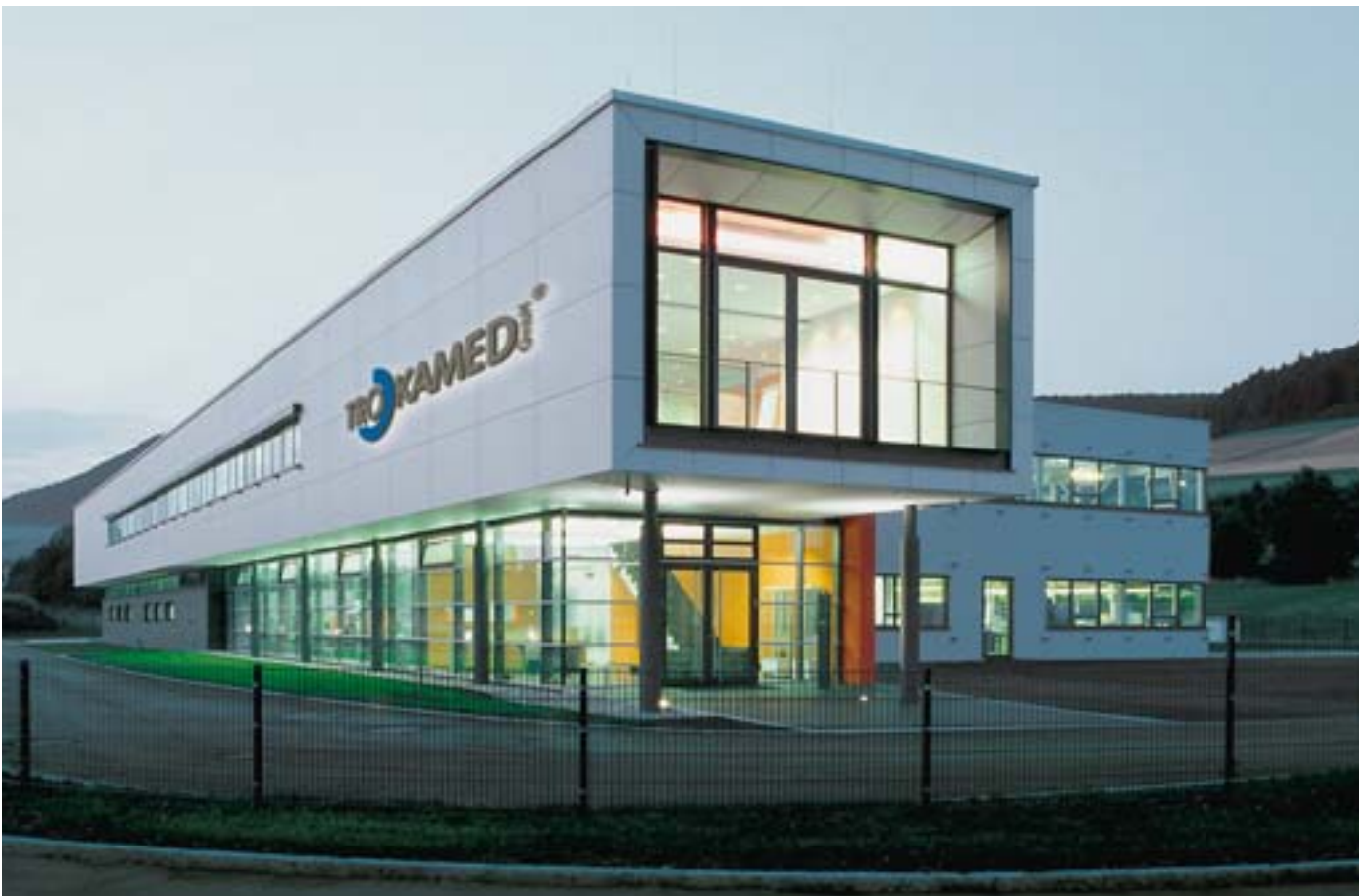
Das Obergeschoss hat eine Länge von 79 m.
