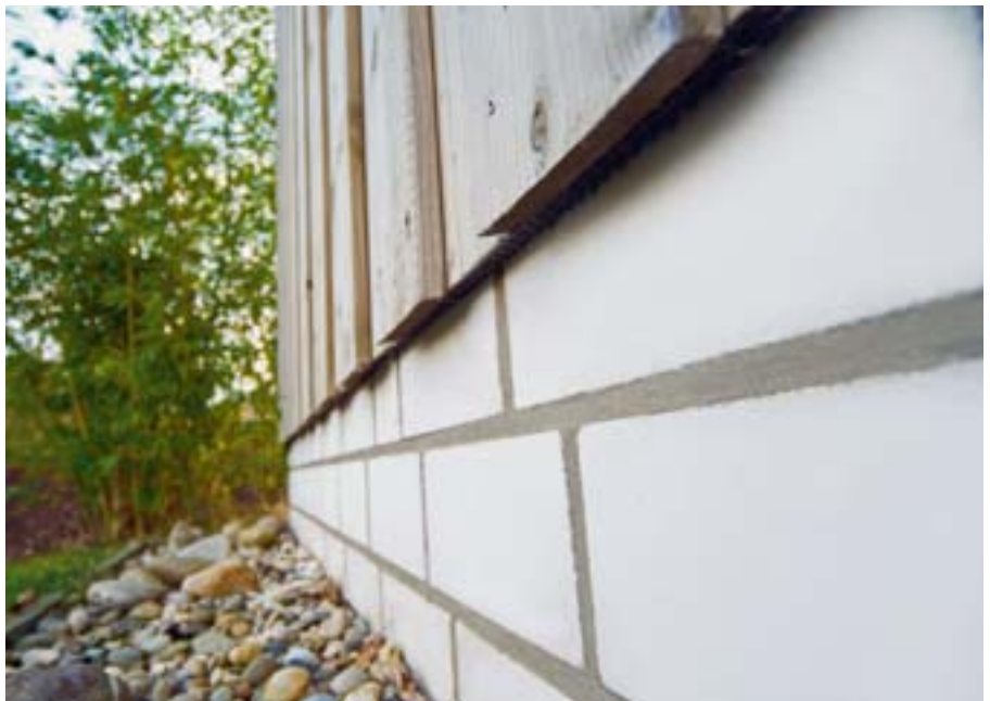
Fußpunktausbildung mit Kiesstreifen
