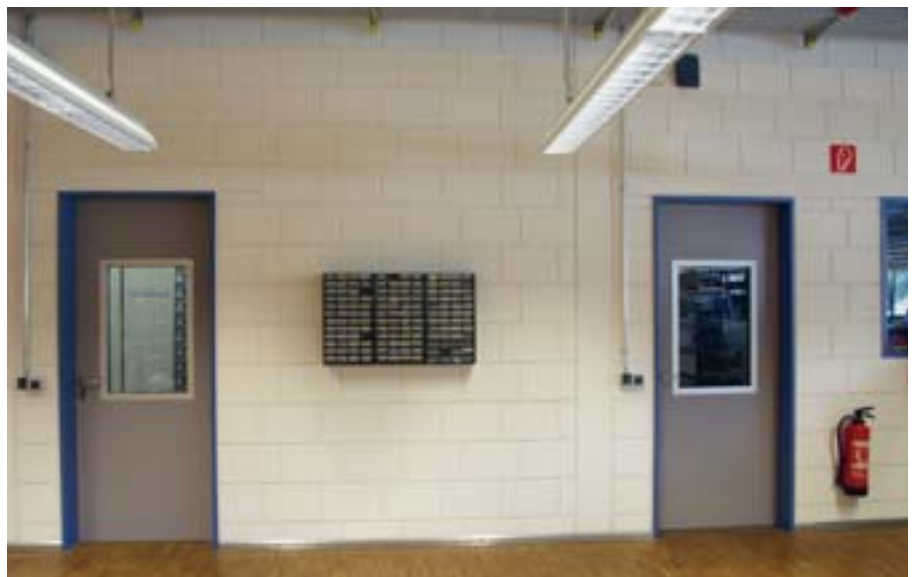
Das Stahlbetonskelett ist mit KS-Fasensteinen ausgefacht.
