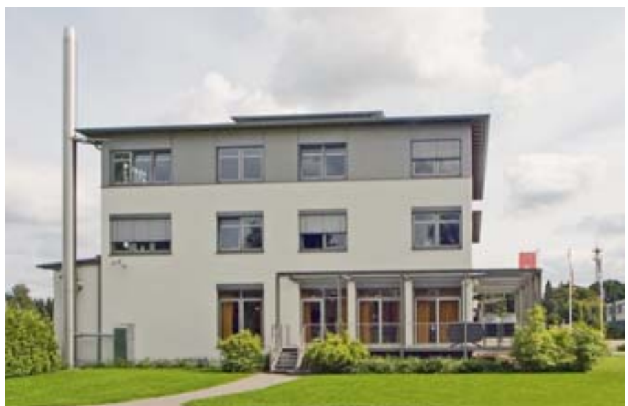
Bild 7: Bürogebäude mit Lochfassade
