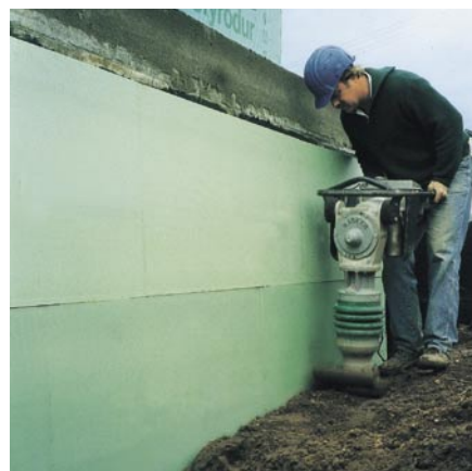
Bild 8/7: Die Baugrube wird lagenweise verfüllt. Die Perimeterdämmplatten sind Schutzschicht für die Abdichtung.
