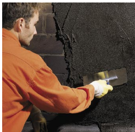
Bild 6/5: Aufziehen der kunststoffmodifizierten Bitumendickbeschichtung (KMB)
