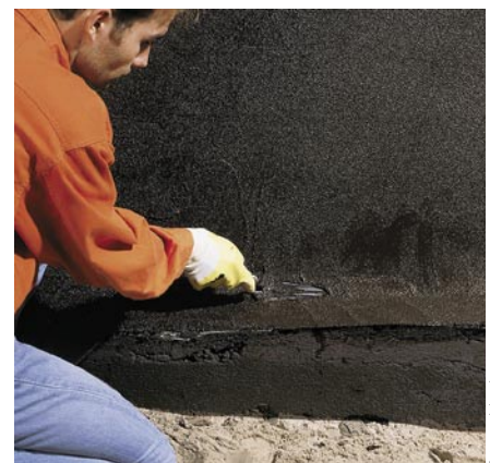
Bild 6/7: Glättziehen der Hohlkehle mit der Zungenkelle
