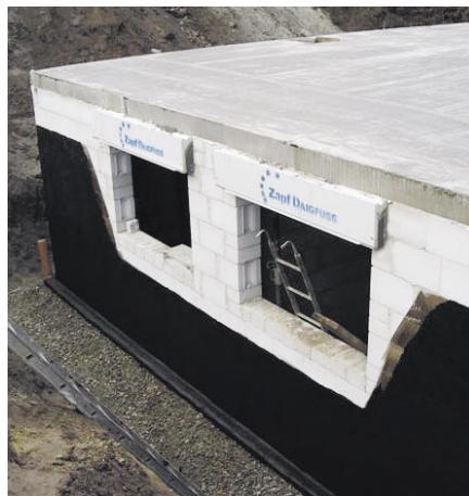
Bild 3/9: Bei Hochkellern oder abgebochten Geländekanten lassen sich normale Fenster verwenden.
