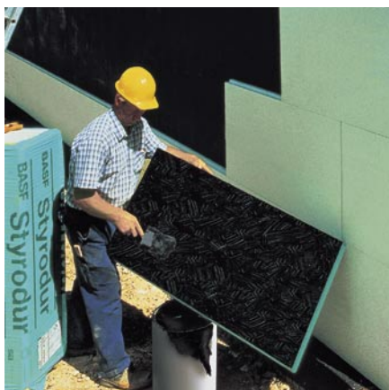
Bild 8/5: Die Perimeterdämmplatten werden mit Bitumenkleber aufgeklebt.
