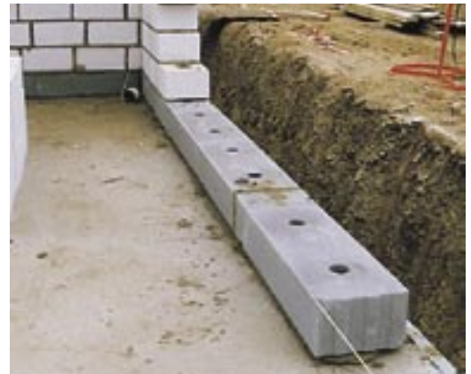
Bild 25: Anlegen der Kimmschicht mit dem KS-ISO-Kimmstein
