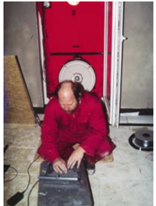
Bild 6: Mit dem Blower-Door-Test wird die Luftdichtheit geprüft.
