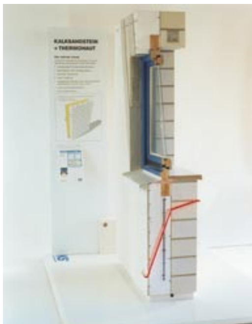
Bild 45: Modell einer KS-Außenwand mit WDVS
