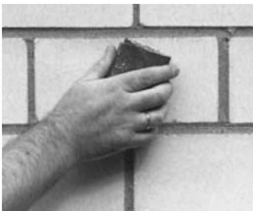
Bild 49: Schonende Reinigung mit Sandpapier, feinste Körnung
