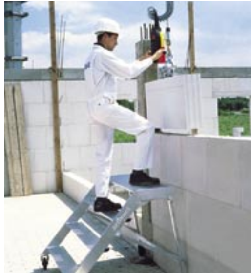
Bild 39: Versetzen von KS XL
