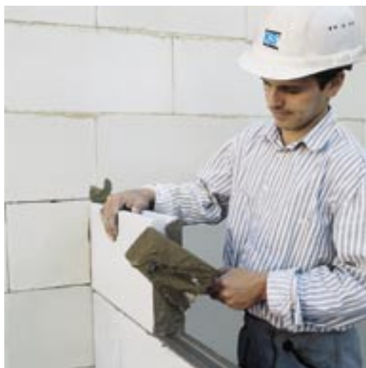
Bild 21: Stumpfstoß einer leichten Trennwand aus KS-Bauplatten
