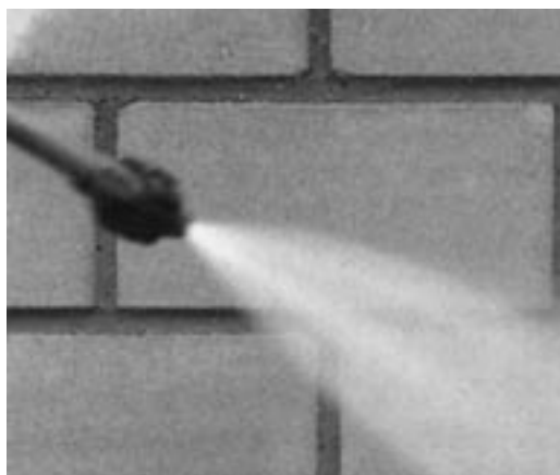
Bild 48: Reinigung mit Dampfstrahlgerät
