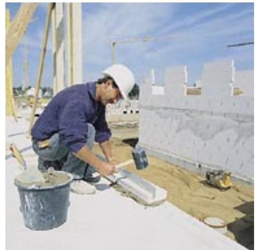
Bild 19: Die Kimmerschicht, mit KS-Kimmsteinen einfach anzulegen
