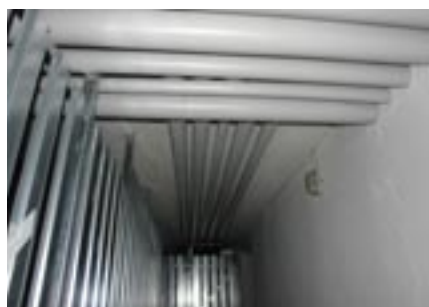
Kellergeschoss-Decke mit Lüftungsrohren
