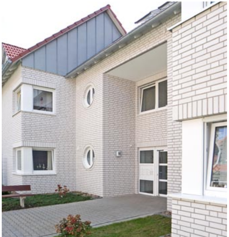
Bild 3: Kalksandstein-Mauerwerk schafft eine helle und einladende Atmosphäre.
