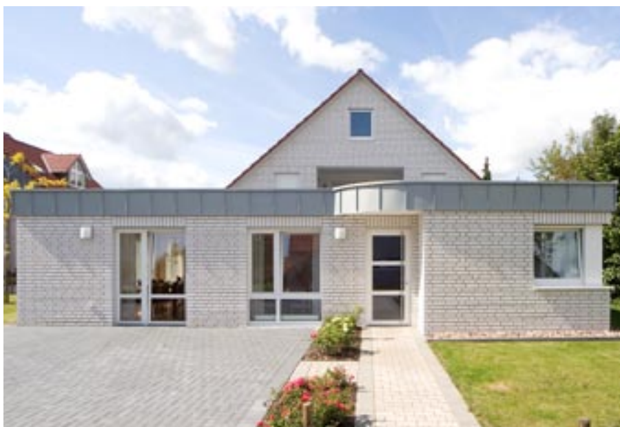
Bild 6: Ein barrierefreier Zugang zum Gebäude bedeutet nicht nur für Senioren hohen Komfort.
