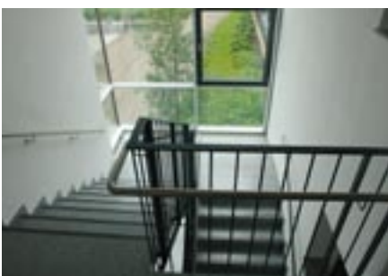
Treppe mit Geländer und Handlauf
