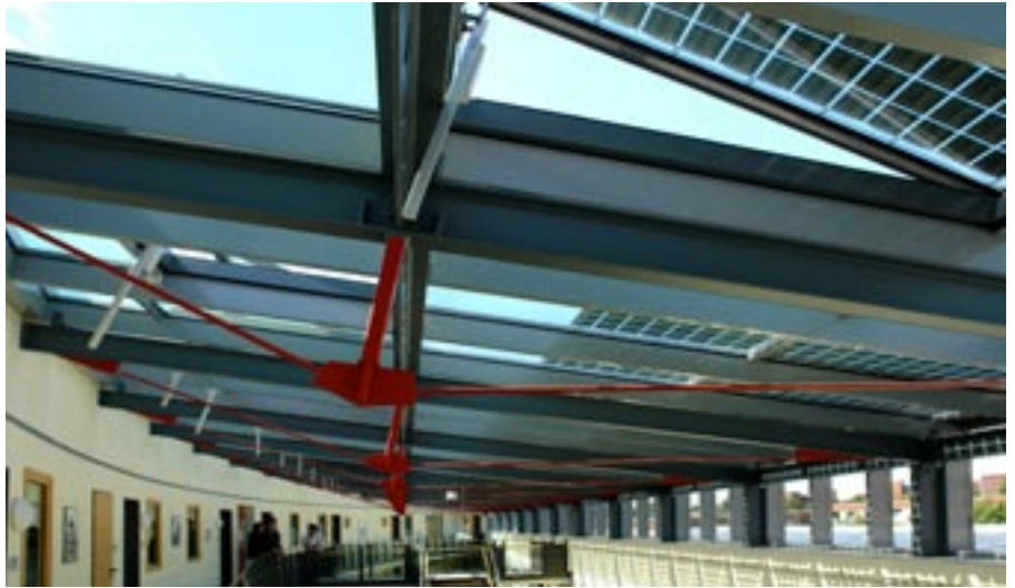
Dachkonstruktion im Bereich des Glasdachs
