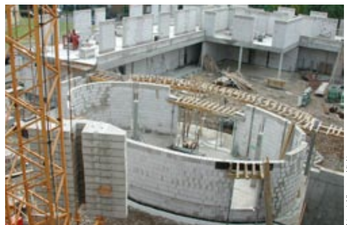
Rohbau mit dem Bereich der ovalen Kapelle
