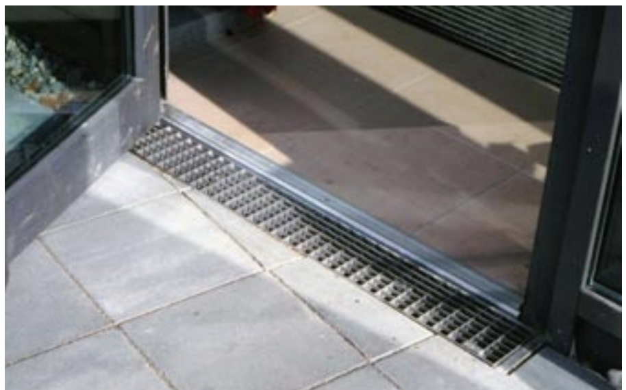
Bild 13: Schwellenfreier Eingangsbereich (Neubau)
