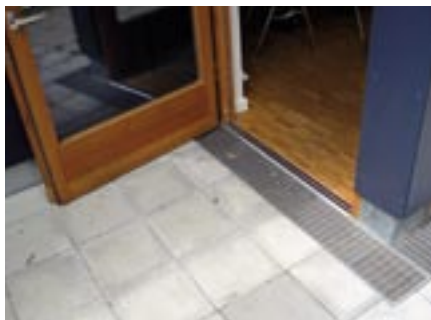
Bild 34: Schwellenfreier Übergang zur Terrasse
