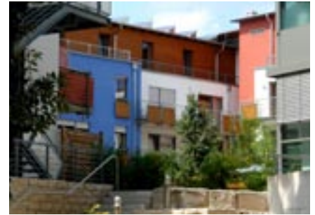
Blick vom Innenhof auf das Pflegeheim
