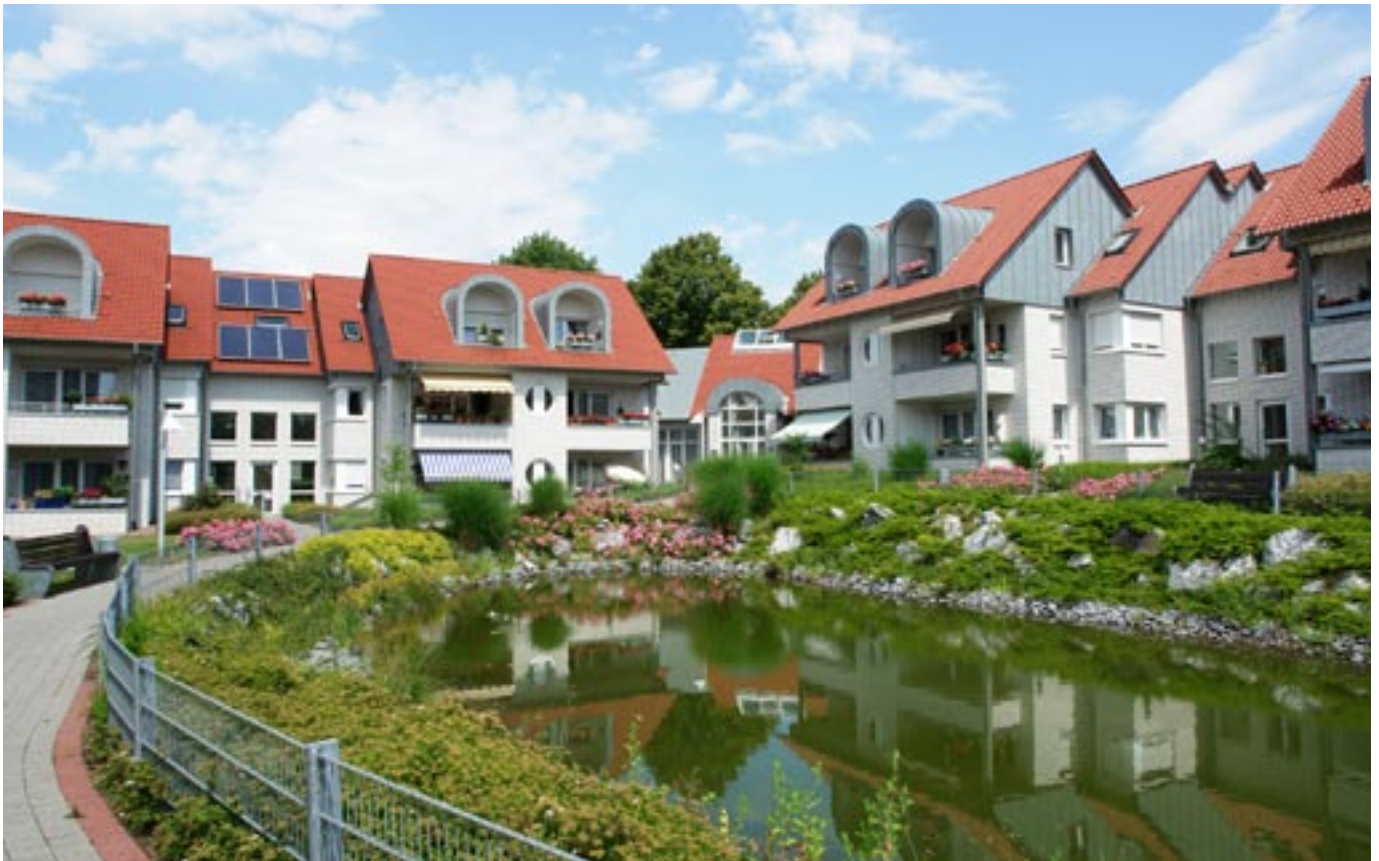
Gemeinschaftsanlage mit dem zentral gelegenen Teich
