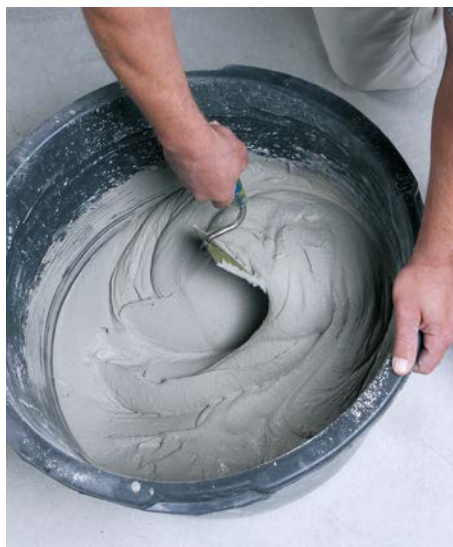
Bild 15 Nach einer Reifezeit und nochmaligem Durchmischen erfolgt die Konsistenzprüfung und Verarbeitung.
