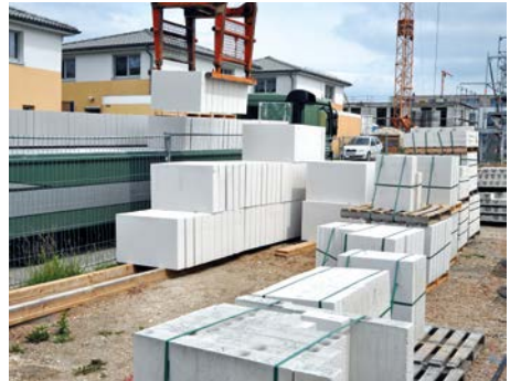
Bild 6 Das Absetzen der Steinstackel erfolgt zweckmäßig auf Paletten oder Bohlenlege.
