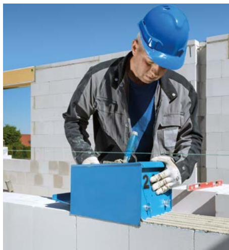
Bild 7 Der Auftrag mit dem Mörtelschlitten und der passenden Zahnschleife führt zu einem gleichmäßigen Mörtelauftrag.
