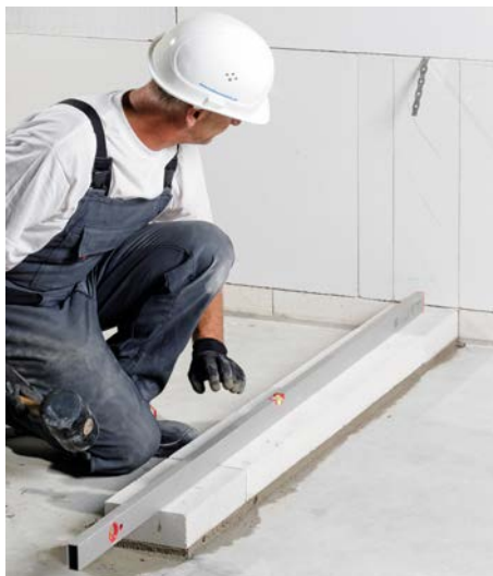
Bild 10 Kimmsteine in Längsrichtung ausrichten
