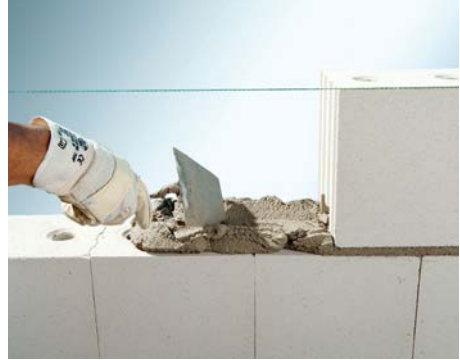
Bild 4 Verarbeitung von Normalmauermörtel
