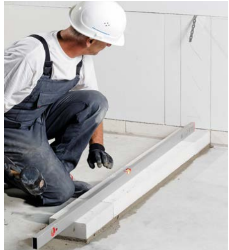
Bild 9 Kimmsteine in Längsrichtung ausrichten
