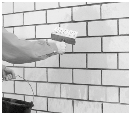
Bild 32 Das Fugenetz ist gründlich vorzunässen, um das „Verdursten“ des Fugenmörtels zu vermeiden.
