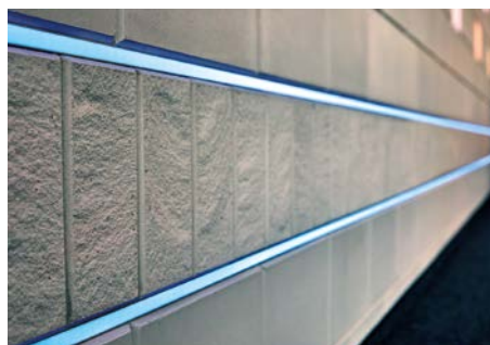
Bild 4 Innensichtmauerwerk aus KS-Fasensteinen kombiniert mit LED-Technik
