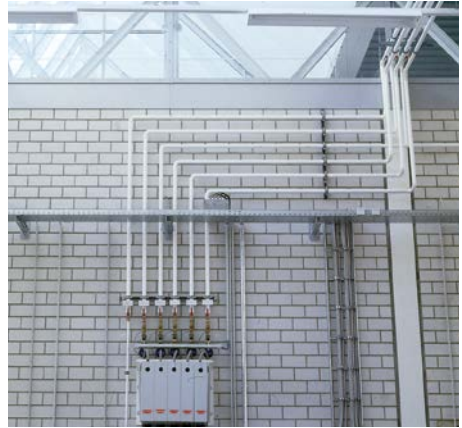
Bild 11 Innensichtmauerwerk aus Kalksandstein mit befestigten Installationsleitungen
