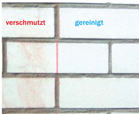
Bild 37 Reinigungseffekt, Beispiel Reinigung mit Schleifpapier, feinste Körnung
