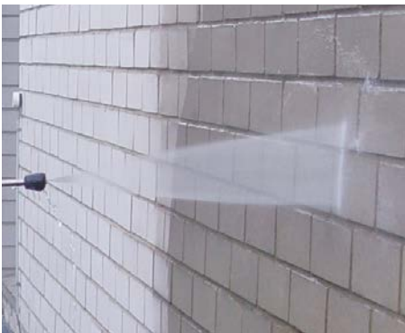
Bild 29 Reinigung mit Dampfstrahlgerät
