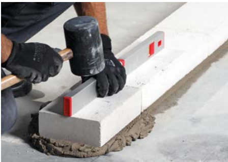
Bild 2 Kontrolle der Ebenheit in Wandlängsrichtung
