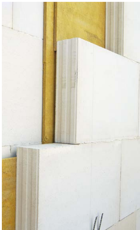
Bild 47 Dicht gestoßene Mineralfaserplatten Typ WTH vermeiden Schallbrücken.
