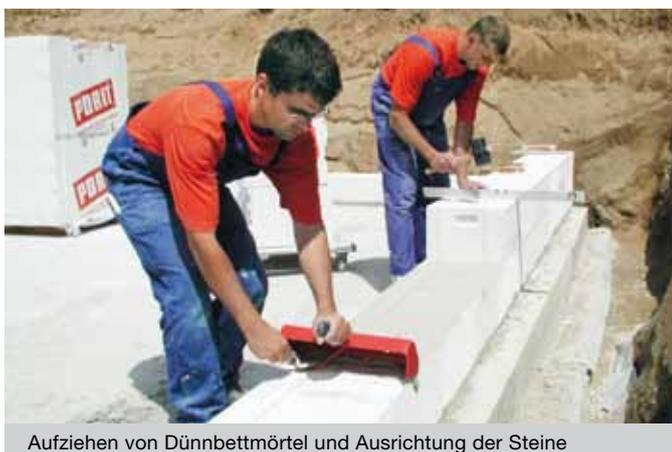
Aufziehen von Dünnbettmörtel und Ausrichtung der Steine
