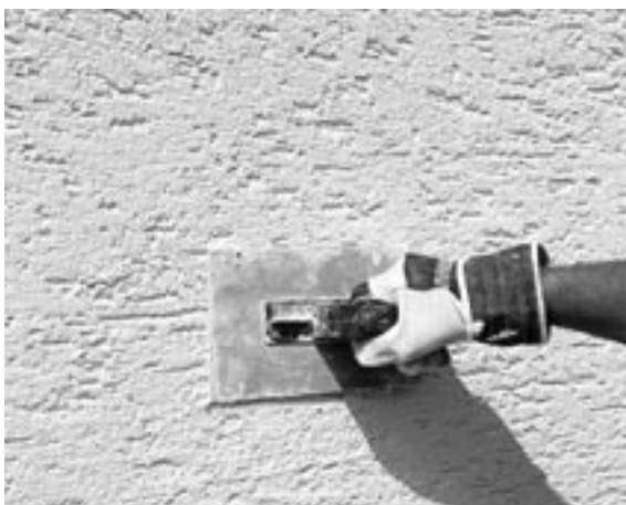
Abb. 10.32: Einlagiger Leichtputz als Außenputz auf Porenbeton-Mauerwerk; Aufbringen der zweiten Schicht in Kornstärke und Strukturierung der Oberfläche
