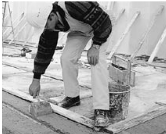
Abb. 10.16: Porenbeton-Wandtafeln; Dünnbettmörtel auf Mörtelausgleichsschicht
