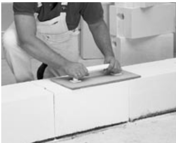
Abb. 10.8: Porenbeton-Plansteine; Beseitigen von ausführungsbedingten Unebenheiten mit einem Schleifbrett
