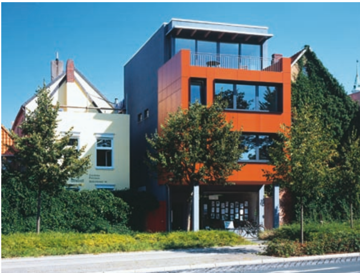
Abb. 11.22: Aufstockung eines Wohn- und Geschäftshauses in Oldenburg
