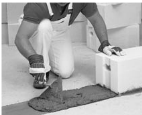
Abb. 10.6: Porenbeton-Plansteine; Auftrag eines Mörtelbetts zwischen Querschnittsabdichtung und erster Steinlage
