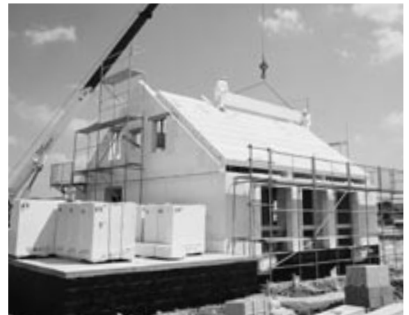
Abb. 10.22: Porenbeton-Dachplatten; Verlegung
