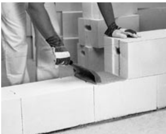
Abb. 10.9: Porenbeton-Plansteine; Auftrag von Dünnbettmörtel mittels Plansteinkelle
