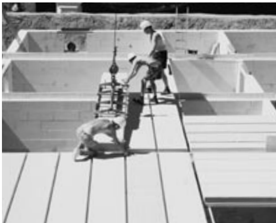
Abb. 10.19: Porenbeton-Deckenplatten; Verlegung mit einem Kran direkt vom Lieferfahrzeug
