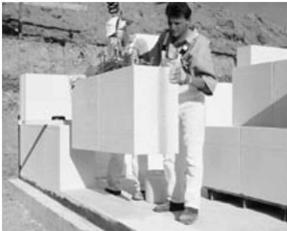
Abb. 10.14: Porenbeton-Planelemente; Versetzen mittels Mini-kran und Greifzange
