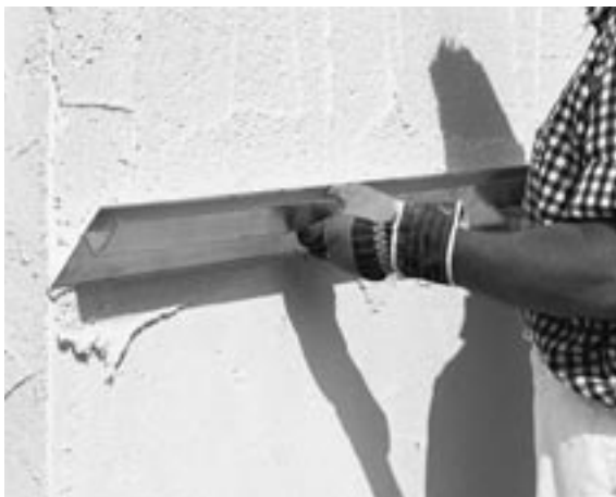
Abb. 10.31: Einlagiger Leichtputz als Außenputz auf Porenbeton-Mauerwerk; Planebenes Abziehen mit einem Richtscheit
