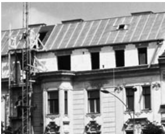
Abb. 3.13: Aufstockung von Gebäuden: Errichtung eines zusätzlichen Geschosses
