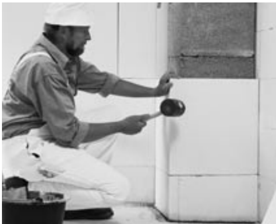
Abb. 3.5 bis Abb. 3.9: Herstellung von Installationskanälen
