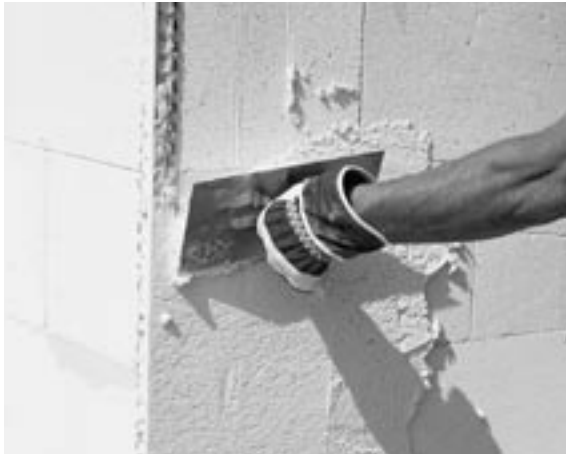
Abb. 10.30: Einlagiger Leichtputz als Außenputz auf Porenbeton-Mauerwerk; Aufbringen der ersten Schicht von Hand
