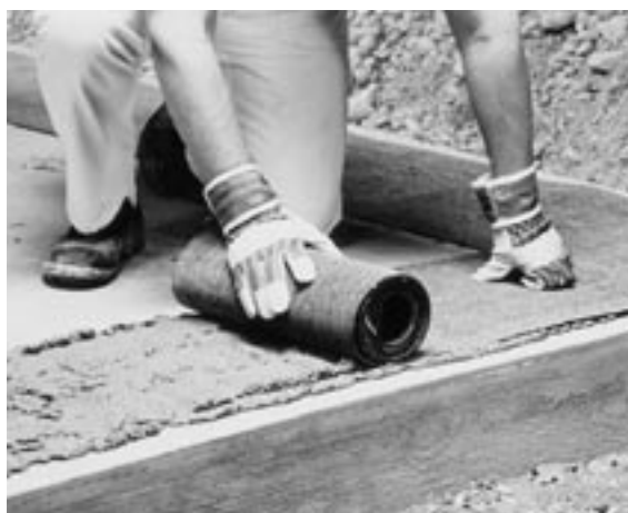
Abb. 10.4: Querschnittsabdichtung aus besandeter Bitumenbahn gegen aufsteigende Feuchte
