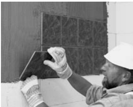
Abb. 10.34: Keramische Beläge; Ansetzen von Fliesen auf Porenbetonmauerwerk im Dünnbettverfahren
