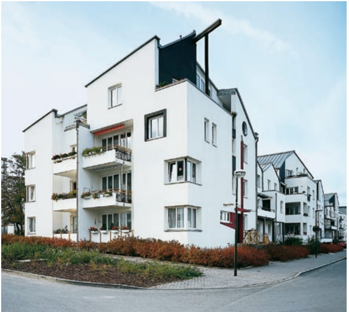
Abb. 11.11a und 11.11b: Wohnanlage in Rostock-Toitenwinkel
