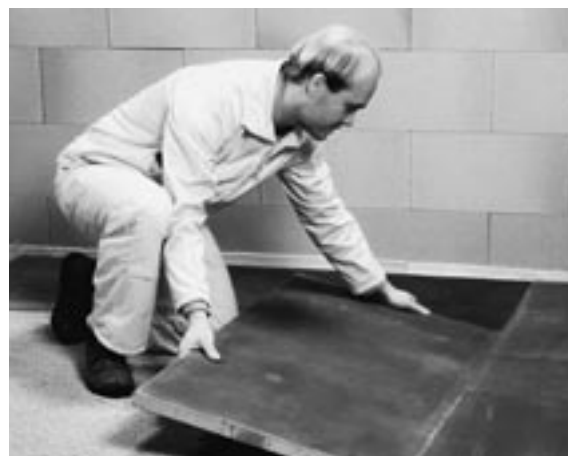
Abb. 3.10 und Abb. 3.11: Fußbodenaufbau aus Porenbeton-Granulat und Trockenestrichplatten
