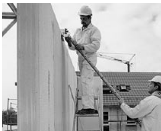
Abb. 10.18: Porenbeton-Wandtafeln; Sicherung durch Streben
