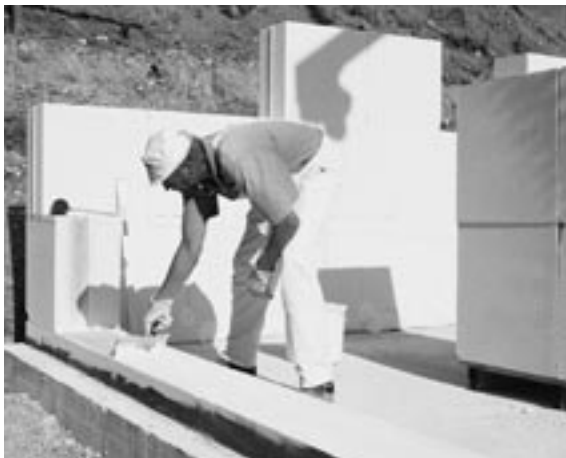
Abb. 10.13: Porenbeton-Planelemente; Anlegen einer Höhenausgleichsschicht
