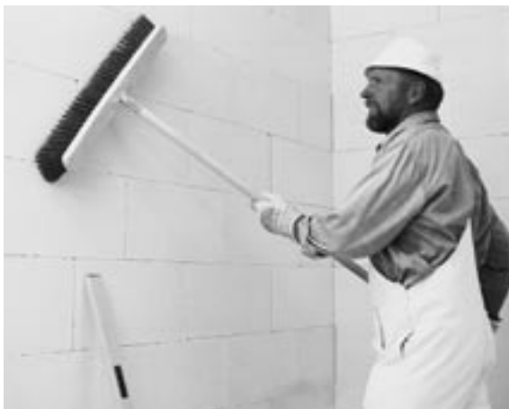
Abb. 10.33: Keramische Beläge; Entfernen von Staub, Verunreinigungen und losen Teilen vor Beginn der Arbeiten
