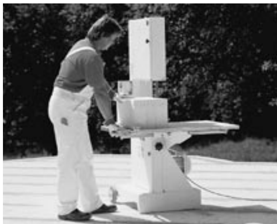
Abb. 10.23 (links): Bearbeitung; Her- stellung von Pass- Stücken per Hand
