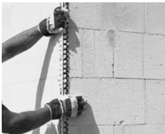
Abb. 10.29: Verputzen von Porenbeton-Wänden; Sicherung von Gebäudekanten durch Eckschutzprofile
