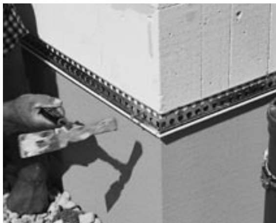
Abb. 10.28: Verputzen von Porenbeton-Wänden; Sicherung von Gebäudekanten durch Sockelabschluss-Schienen
