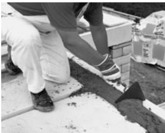
Abb. 10.21: Porenbeton-Deckenplatten; Ringanker- und Fugenbetonierung
