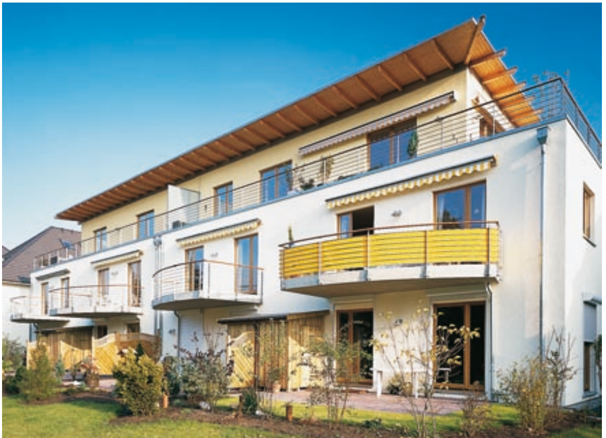
Abb. 11.13: Mehrfamilienhaus in Hamburg-Habichtshorst
