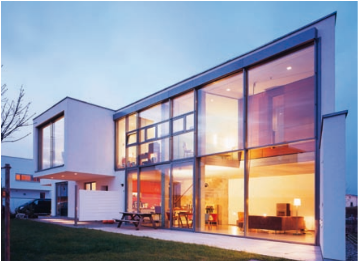
Abb. 11.3a und 11.3b: Einfamilienhaus in Lübeck
