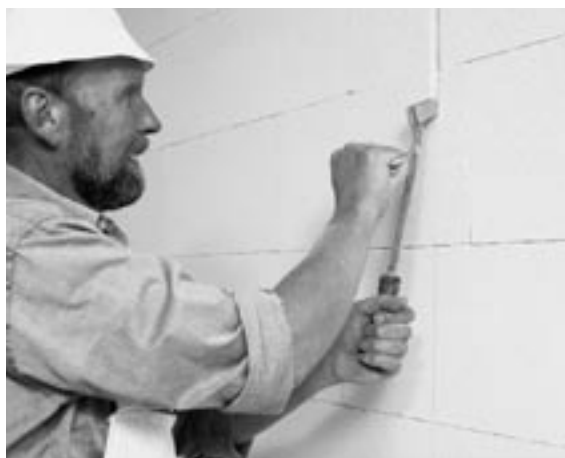
Abb. 10.25 (links): Bearbeitung; Bohren von Aussparungen für Unterputzschalter und Verteilerdosen mit einem Steckdosen- bohrer
