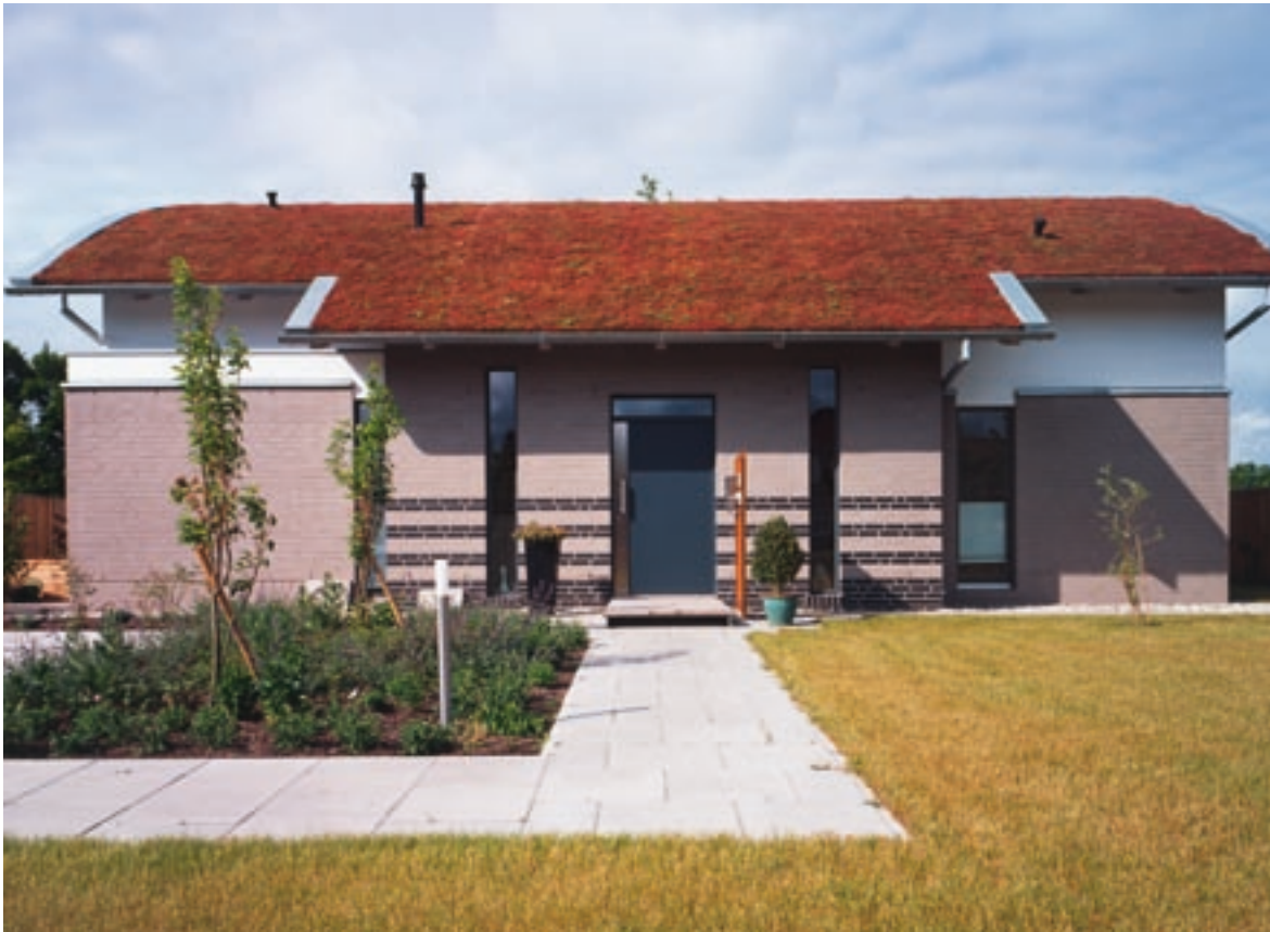
Abb. 11.4a und 11.4b: Einfamilienhaus in Ost- friesland
