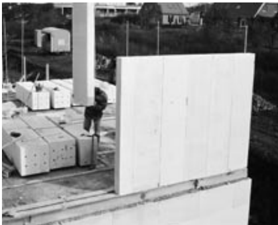
Abb. 2.6 (links): Porenbeton-Wandtafeln für tragende Außenwände
