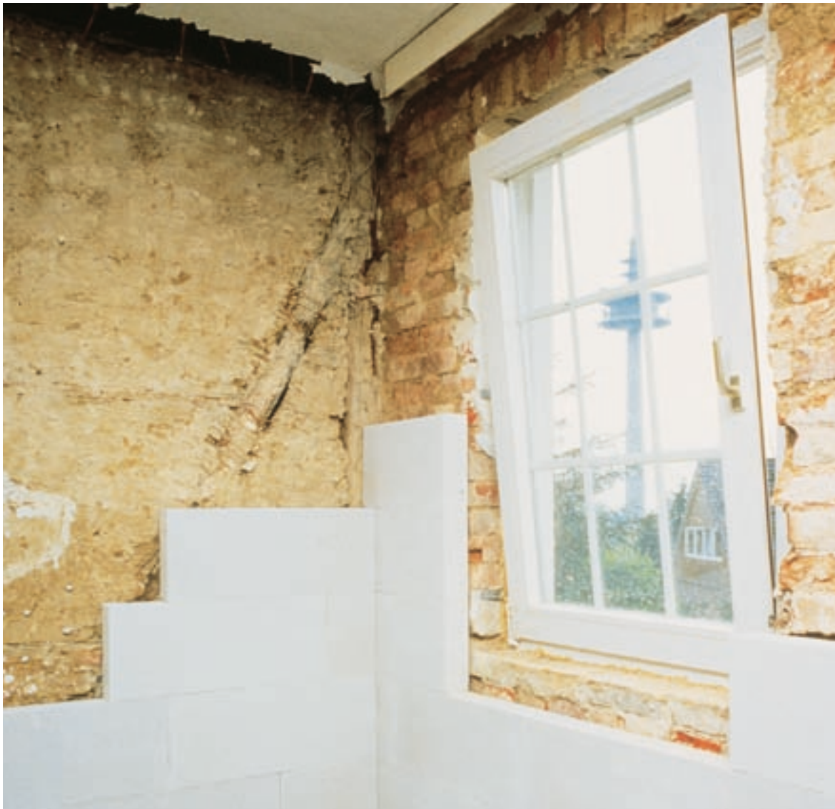
Abb. 11.18d und 11.18e: Sanierung Glandorpshof in Lübeck
