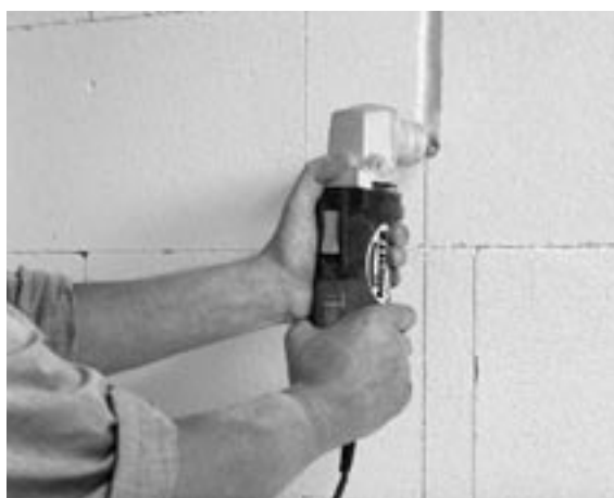
Abb. 10.27: Bear- beitung; Fräsen von Leitungsschlitzen mit einer Mauerfräse
