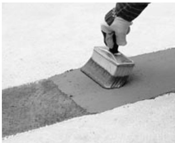
Abb. 10.5: Querschnittsabdichtung aus flexibler Dichtungsschlämme gegen aufsteigende Feuchte
