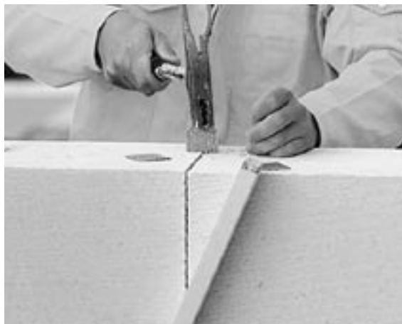
Abb. 10.17: Porenbeton-Wandtafeln; Fixierung durch Justierplättchen
