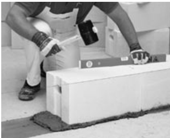
Abb. 10.7: Porenbeton-Plansteine; Ausrichten mit Wasserwaage und Gummihammer
