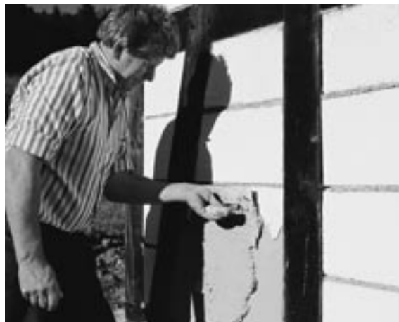
Abb. 10.44 bis 10.49: Ausmauerung von Holzfachwerk
