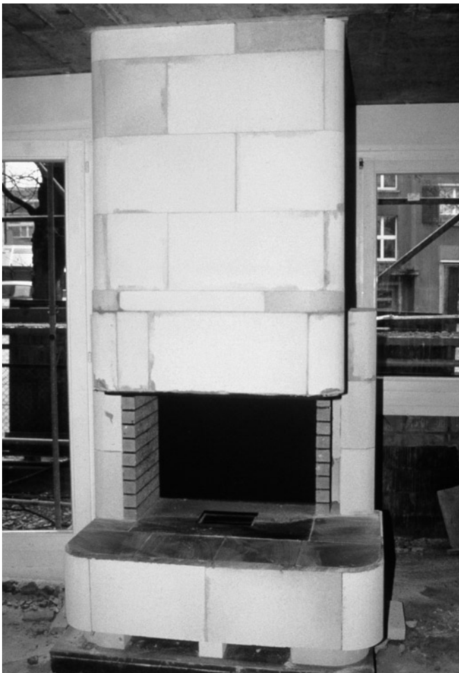
Abb. 10.6: Sockelabmauerung und Verkleidung eines Kachelofens mit Porenbeton
