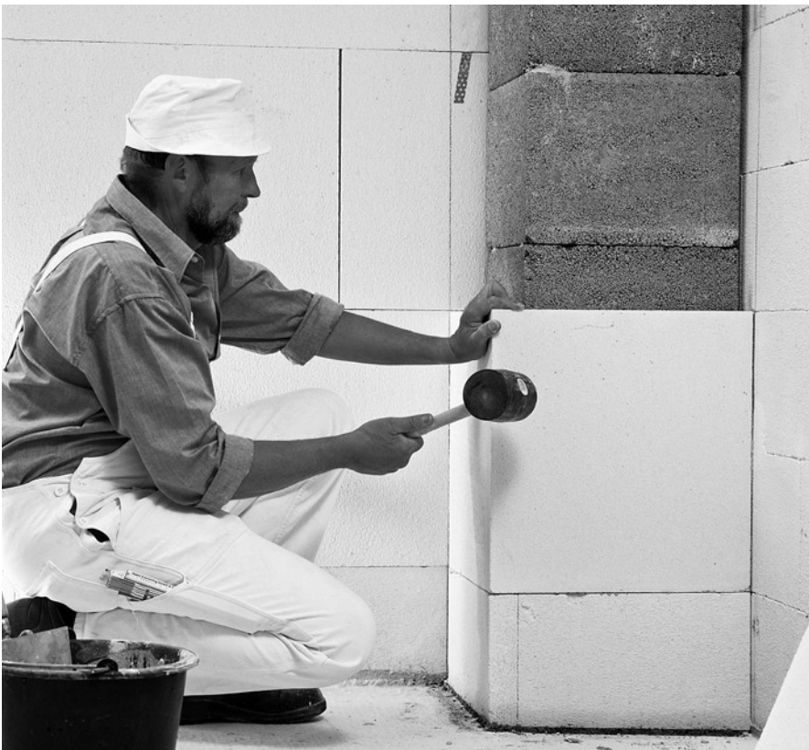
Abb. 10.4: Kaminabmauerung mit Porenbeton-Planbauplatten
