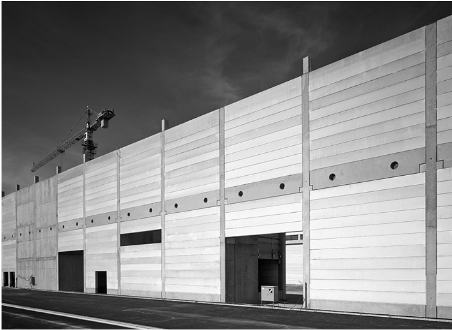
Abb. 3.3: Die Wände der Messe Friedrichshafen wurden aus Porenbeton sowie einer Stahlbeton-Fertigteil-Skelettkonstruktion errichtet.
