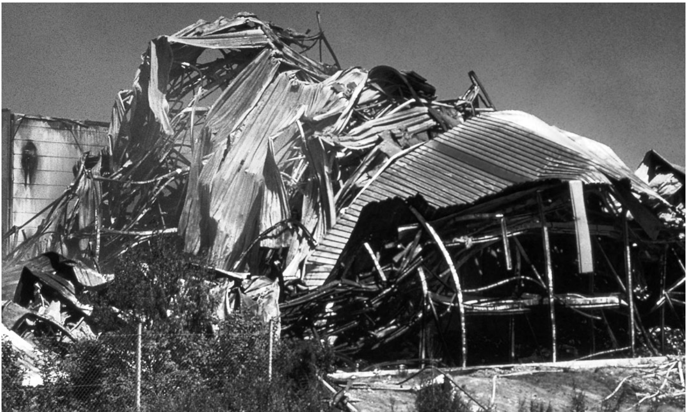
Abb. 9.3: Brand einer Lagerhalle: Die intakte Porenbeton-Brandwand verhinderte einen Übergriff des Brandes auf die zweite Halle
