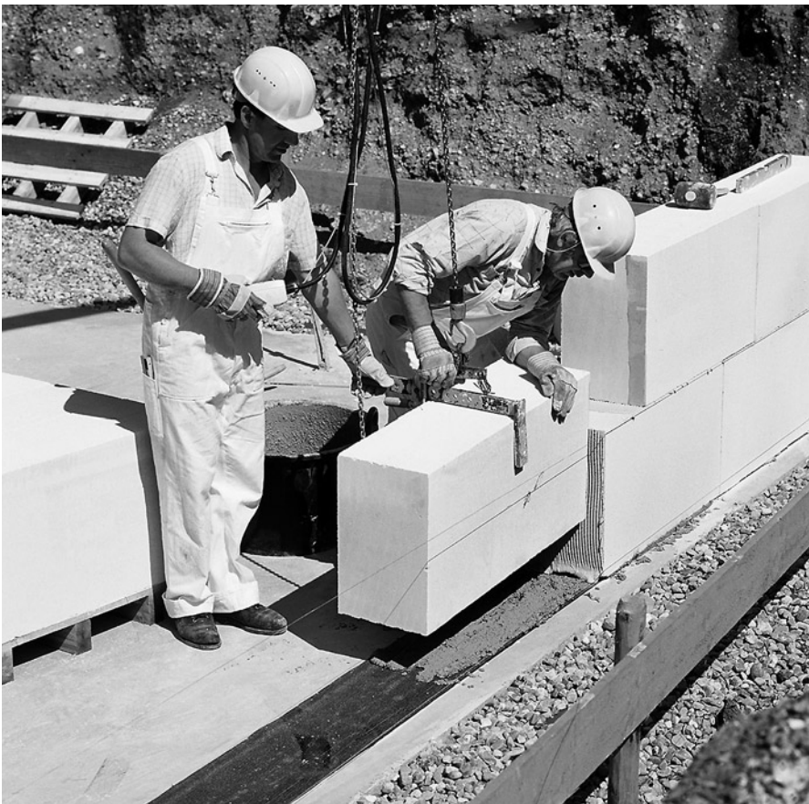
Abb. 5.3: Wände aus Porenbetonprodukten: Schneller und einfacher Einbau von Porenbeton-Plansteinen und -Planelementen im Dünnbettverfahren
