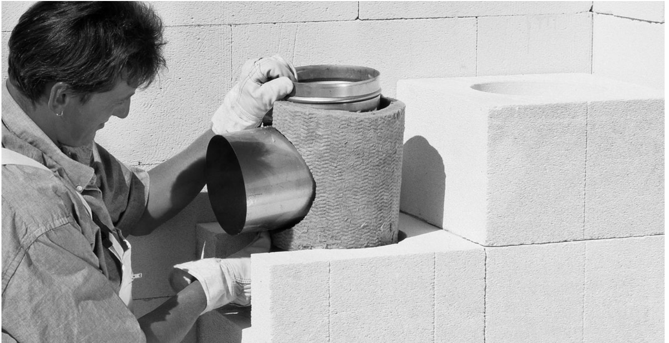
Abb. 10.5: Versetzen und Anpassen des Rauchanschlussrohres für den Kachelofen
