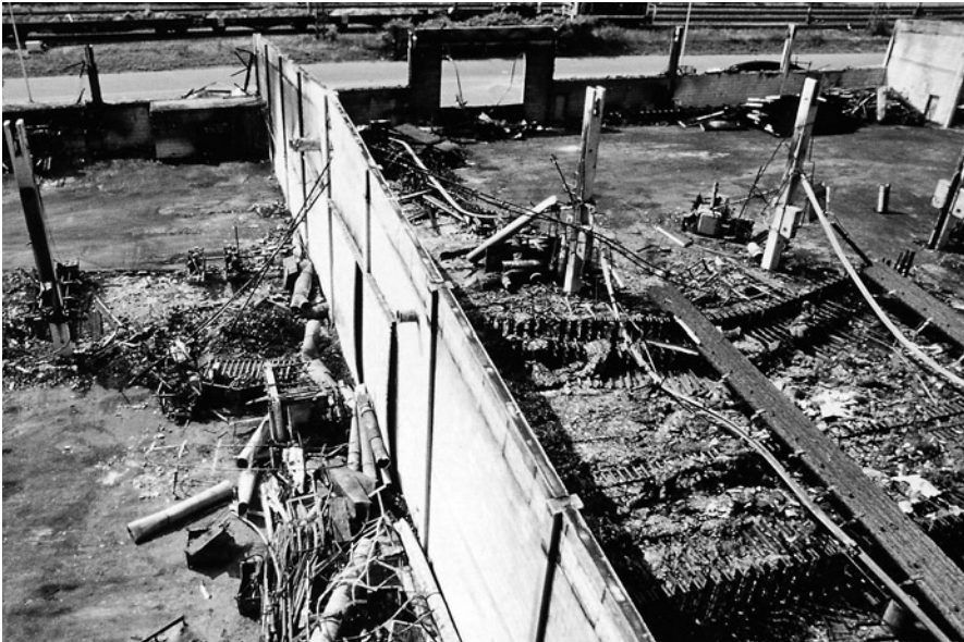
Abb. 5.29: Außenwände und Innenwand mit Dachüberstand aus Wandplatten aus Porenbeton mit Stahlbetonstützen als Brandwände
