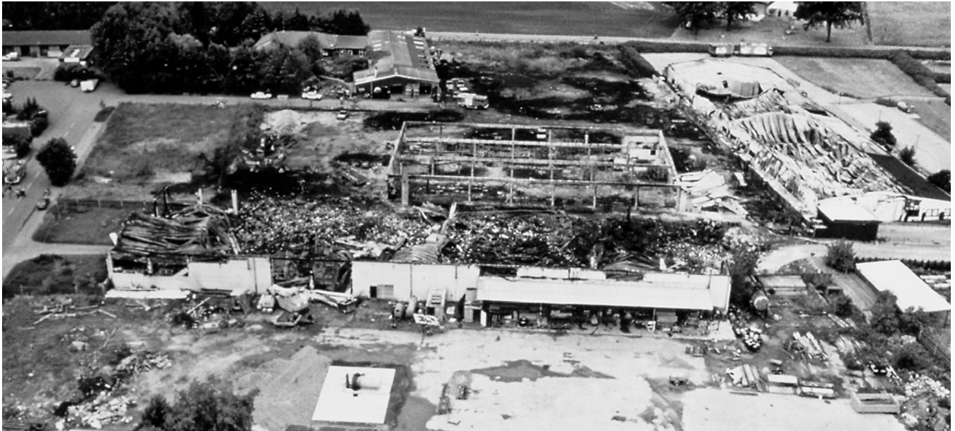
Abb. 9.6: Im abgebildeten Schadensfall konnte das Feuer von einem 20 Meter entfernten Gebäude (rechts) über geparkte Fahrzeuge hinweg auf die Halle (links) zugreifen. Eine Porenbeton-Außenwand hätte das verhindern können (Foto: Allianz)
