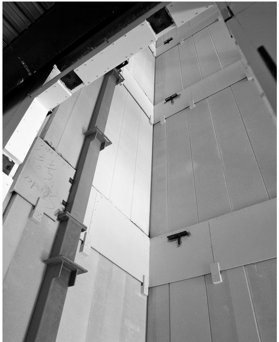
Abb. 3.4: Ausführung der Wände an den Treppenhäusern und Fahrstuhlschächten des Commerzbank-Hochhauses in Frankfurt/M. aus bewehrten Porenbeton-Wandplatten
