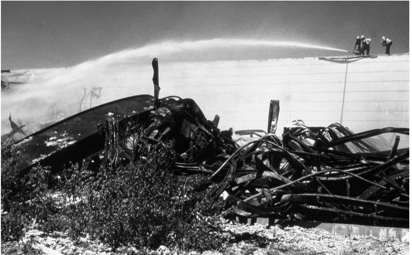
Abb. 9.2: Brand einer Lagerhalle: Von der intakten Porenbeton-Brandwand konnten wirksame Löscharbeiten durchgeführt werden
