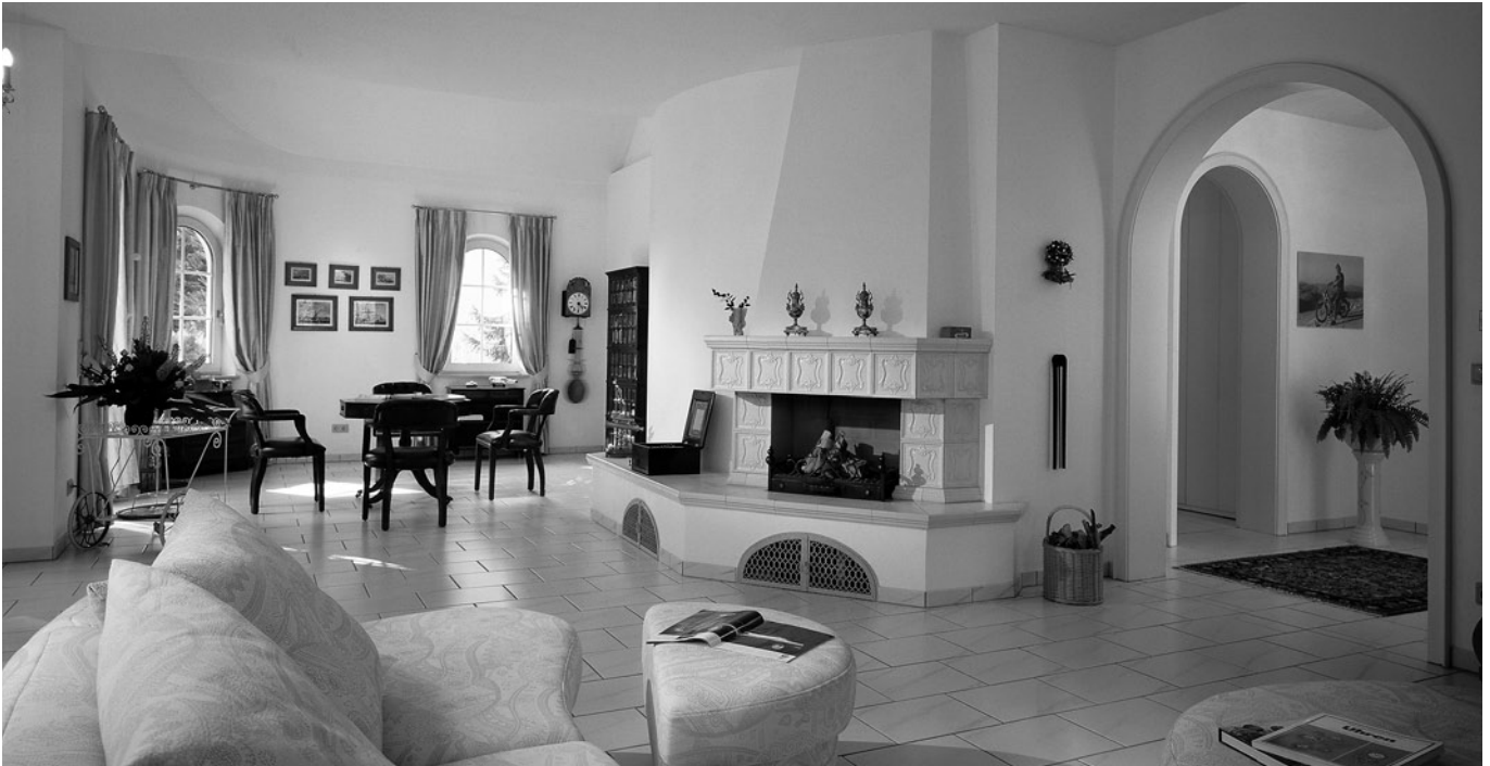
Abb. 10.8: Mit Porenbeton verkleideter und abgemauerter Kachelofen in einem Wohnraum
