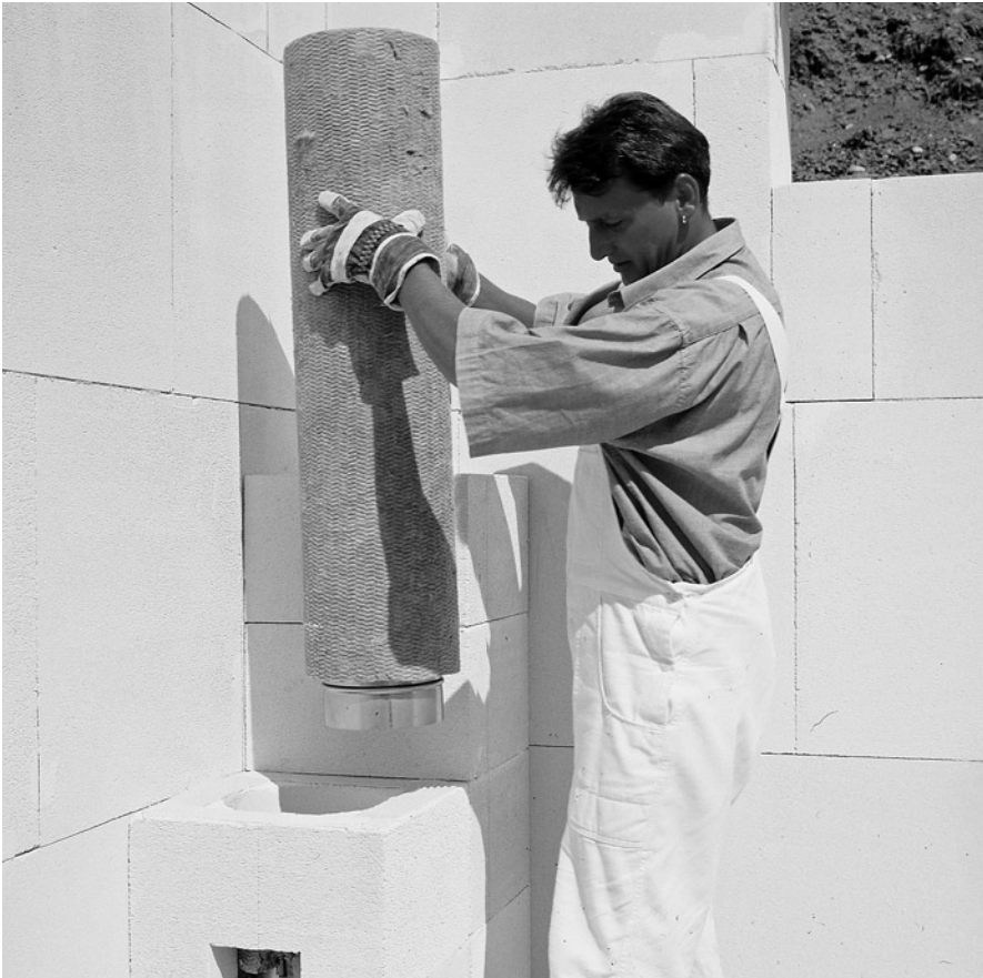
Abb. 10.3: Versetzen des Kaminrohres mit Dämmung in Formsteine aus Porenbeton
