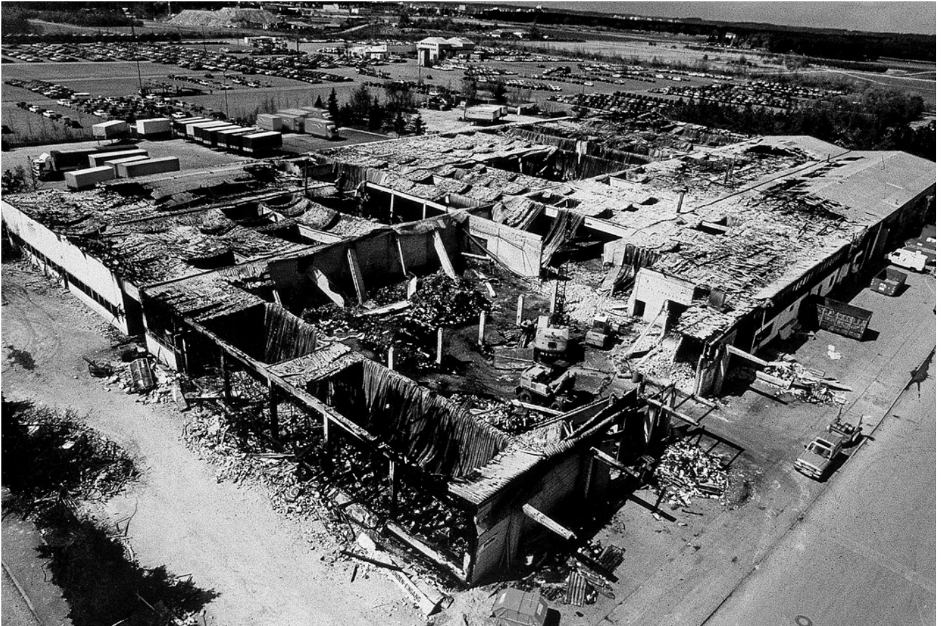
Abb. 9.1: Eine 8500 m 2 große Halle war durch Brandwände in sieben Brandabschnitte unterteilt. Trotzdem konnte auch ein Großeinsatz der Feuerwehr einen Totalschaden nicht verhindern, da sich das Feuer über das nicht brandsichere Dach ausbreitete (Foto: Versicherungskammer Bayern, München)
