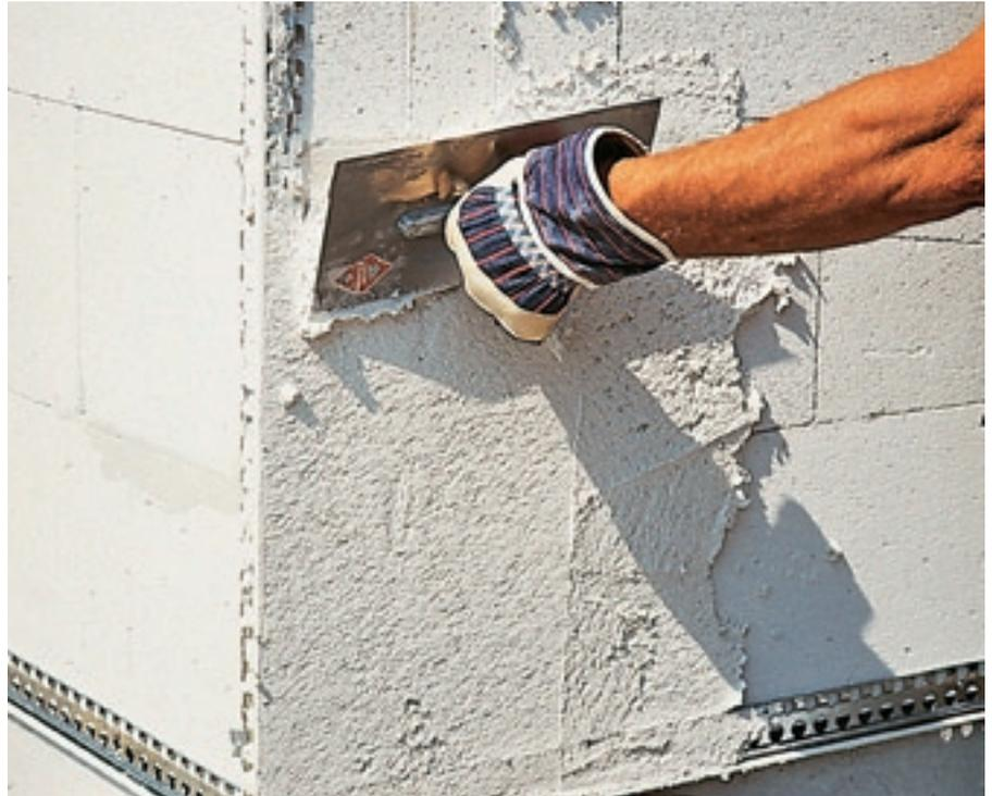
Bild 6 Einlagiger Leichtputz auf Porenbetonmauerwerk; Aufbringen der ersten Schicht von Hand
