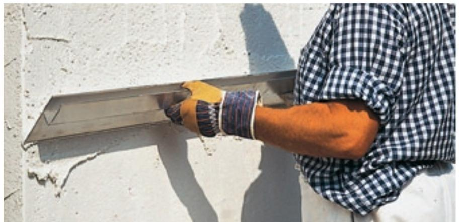
Bild 7 Einlagiger Leichtputz auf Porenbetonmauerwerk; Planebenes Abziehen mit einem Richtscheit
