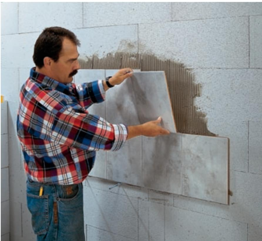
Bild 32 Ansetzen keramischer Beläge im Dünnbettverfahren
