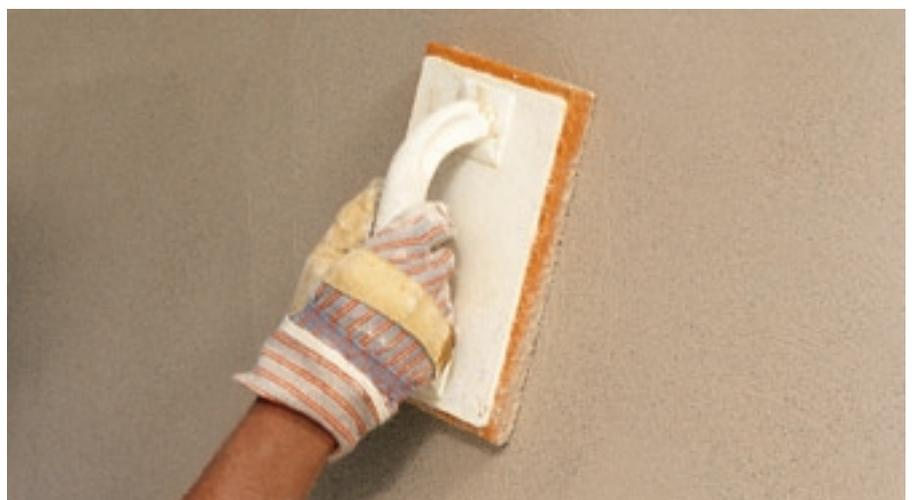
Bild 12 Ebenen des Innenputzes mit einem Filzbrett
