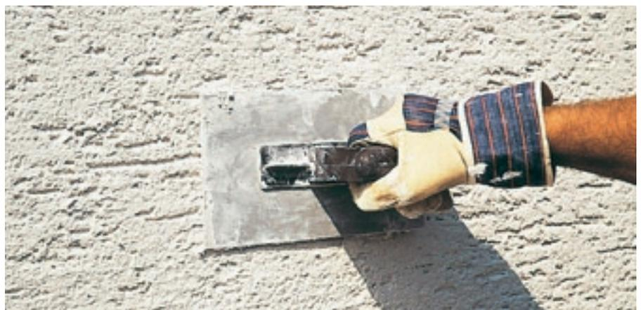
Bild 8 Einlagiger Leichtputz auf Porenbetonmauerwerk; Zweite Schicht in Kornstärke auftragen und strukturieren
