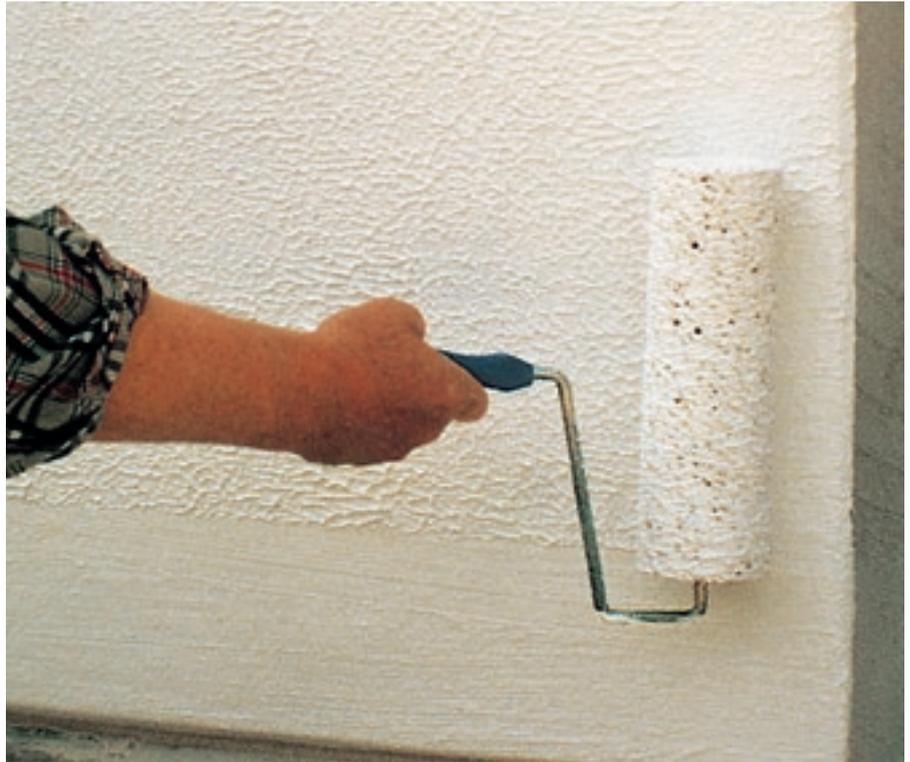
Bild 20 Porenbetonbeschichtung auf Dispersionsacrylatbasis mit strukturierter Oberfläche; Auftragen der Schlussbeschichtung mit Schaumstoffstrukturwalze
