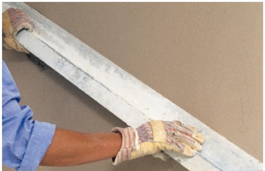
Bild 11 Planebenedes Abziehen des Innenputzes mit einem Richtscheit
