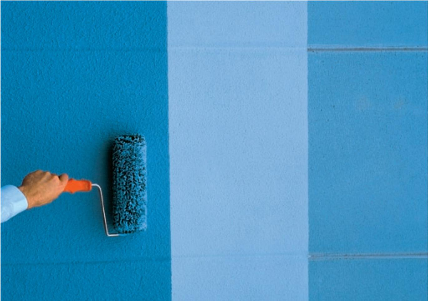
Bild 21 Porenbetonbeschichtung auf Dispersionssilikatbasis mit strukturierter Oberfläche; Auftragen der Schlussbeschichtung mit Lammfellwalze
