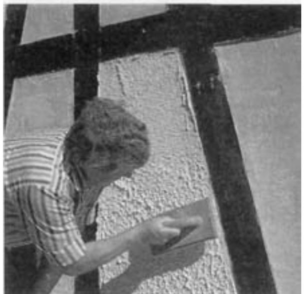
Abb 17: Das Anpassen von Porenbetonsteinen an vorhandene Fachwerkstrukturen geschieht mit einfachen Mitteln, aber mit großer Genauigkeit.
