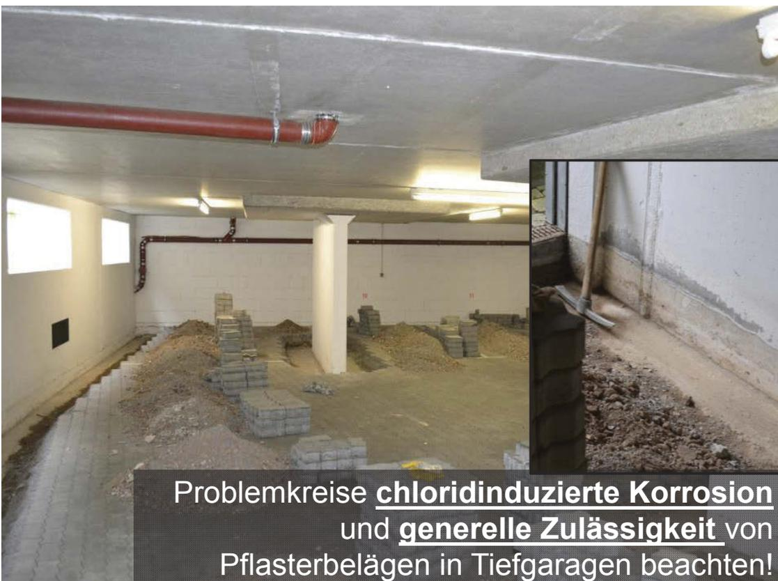
Problemkreise chloridinduzierte Korrosion und generelle Zulässigkeit von Pflasterbelägen in Tiefgaragen beachten!
