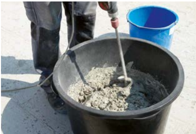
Normalmauermörtel für die Kimmschicht gemäß Herstellerangaben anmischen.
