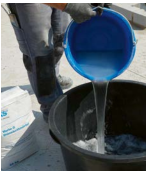
Zum Anrühren des Dünnbettmörtels die vorgeschriebene Menge Wasser gemäß den Herstellerangaben bereitstellen.
