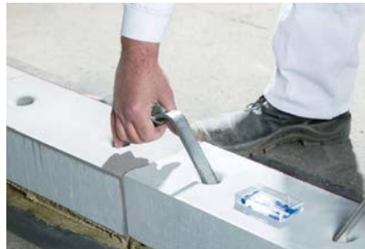
Kimm- oder Wärmedämmsteine im Mörtelbett verlegen und in Längs- und Querrichtung planeben ausrichten. Anschließend überschüssigen Mörtel entfernen.
