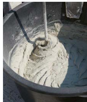
Mit vorgelegter Wassermenge und Rührquirl in verarbeitungsgerechter klumpenfreier Konsistenz durchmischen. Nach ausreichender Reifezeit (etwa 5 min) wird der Mörtel noch einmal durchgequirlt und ist dann verarbeitungsfähig.
