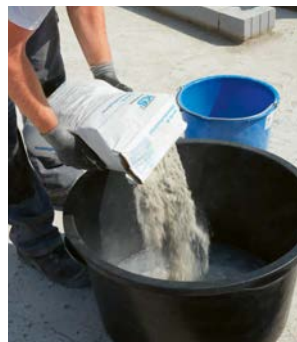
Den Inhalt des Mörtelsacks nach und nach in das Wasser schütten.
