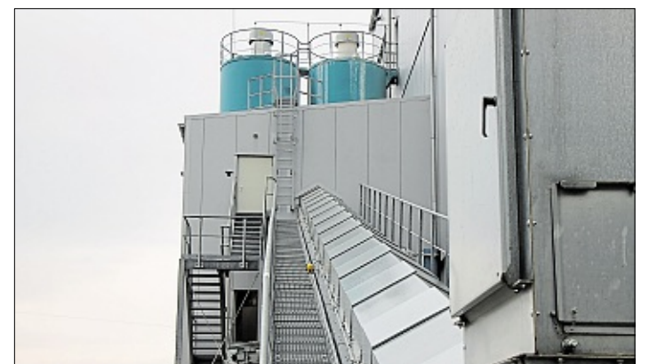
Ab zur Verarbeitung: Hier bahnt sich der Sand seinen Weg.
