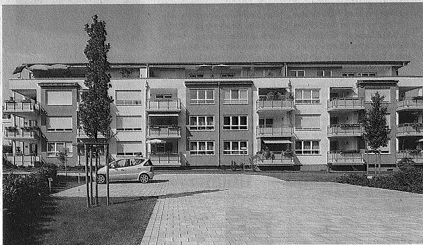
Mit Kalksandstein lassen sich soziale Wohnungsbauprojekte wirtschaftlich realisieren.
