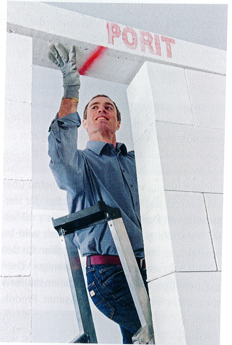
Der einfach zu verarbeitende Porenbeton ist für den nachträglichen Einbau von Zwischenwänden bestens geeignet.
