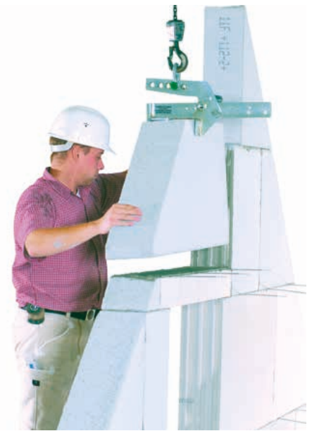
Maßgenau werden die im KS-Werk fertig zugeschnittenen Passsteine auf der Baustelle nach dem Wandverlegeplan rationell mit einem Versetzgerät vermauert. | Foto: KS-Plus
