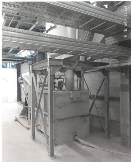
Durch den Nasswäscher kann nasser Staub abgesaugt werden, der in Schlamm umgewandelt wird.
