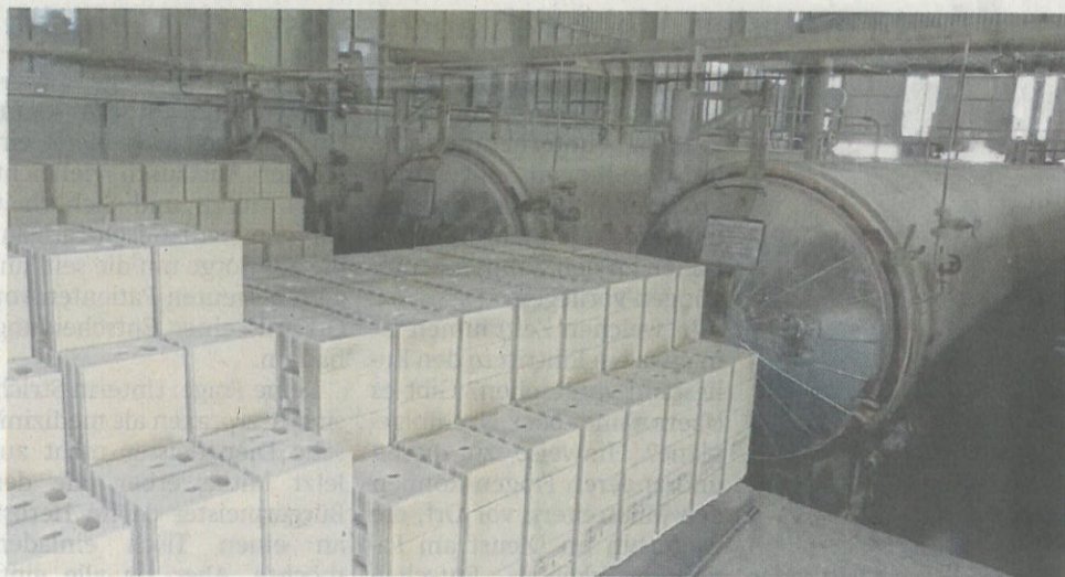
Fünf dieser Autoklaven (Drucköfen) werden im Wickeder Cirkel-Werk betrieben.
