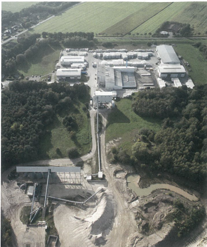
Sand, der Hauptzuschlagstoff des Kalksandsteins, wird in unmittelbarer Nähe, teils sogar direkt auf dem Werks Gelände gewonnen.
