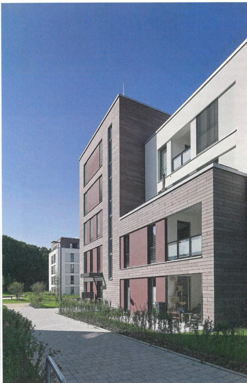
Statt wie ursprünglich geplant die Wände aus Holz zu bauen, entschied sich der Auftraggeber für die wirtschaftlichere Lösung von großformatigen Kalksandstein-Planelementen aus dem Bausystem KS-Plus.
