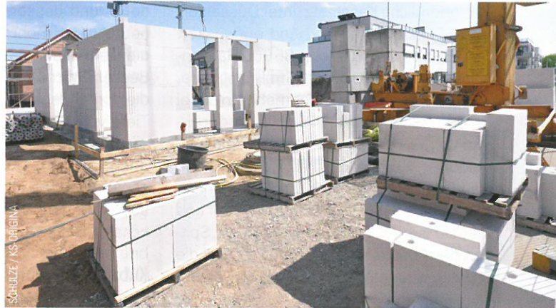
Je nach Baufortschritt werden die Paletten wand- oder geschossweise auf die Baustelle geliefert und genau dort platziert, wo die Steine zu vermauern sind.
