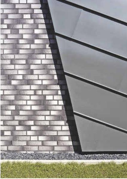
Die Materialkombination und der Stehfalz parallel zur Dachneigung sind gestaltprägend.
