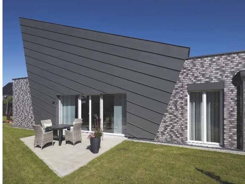
Markant: Das Dach wird durch eine Zinkblechverkleidung um die zweischalige Außenwand aus Kalksandstein und Klinker weitergeführt.
